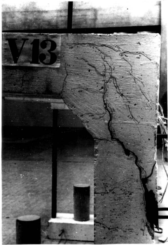
Figura 3.7 - Fotos das fissuras dos modelos V13 e V15.
