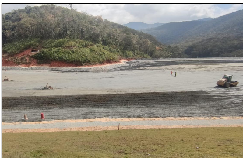
Figura 3-7 – Vista da construção da pilha de rejeitos com uso de rolo compactador liso (Mineradora, 2023).
