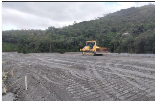
Figura 3-5 – Compactação da camada com trator de esteira D6 (Mineradora, 2023).
