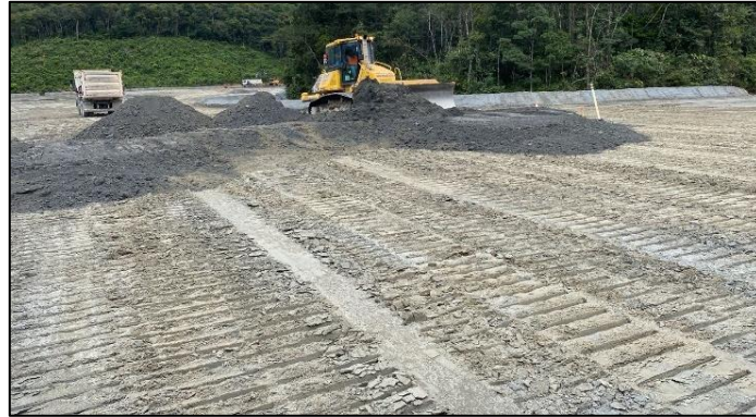
Figura 3-4 – Lançamento da 1ª camada do Aterro Experimental (Mineradora, 2023).
