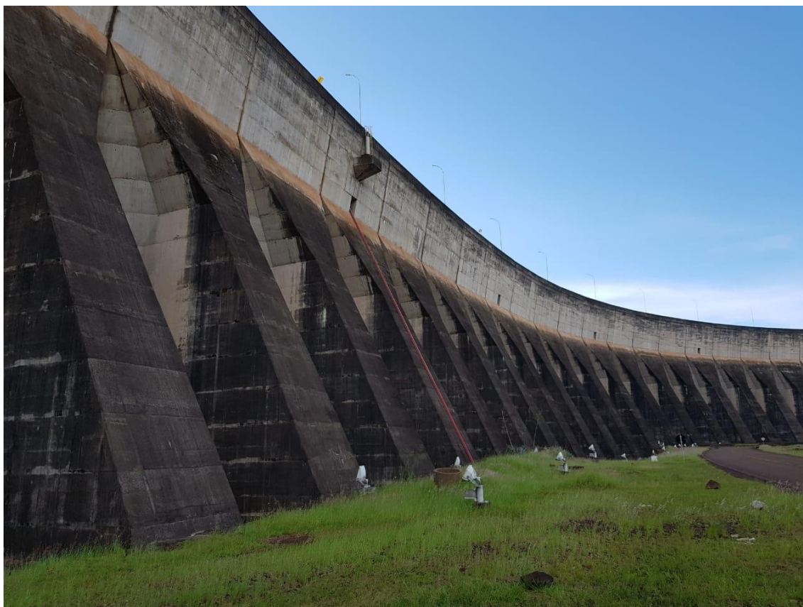
Figura 16. Blocos de contraforte da barragem lateral direita - vista de jusante – Fonte: Autoria própria
