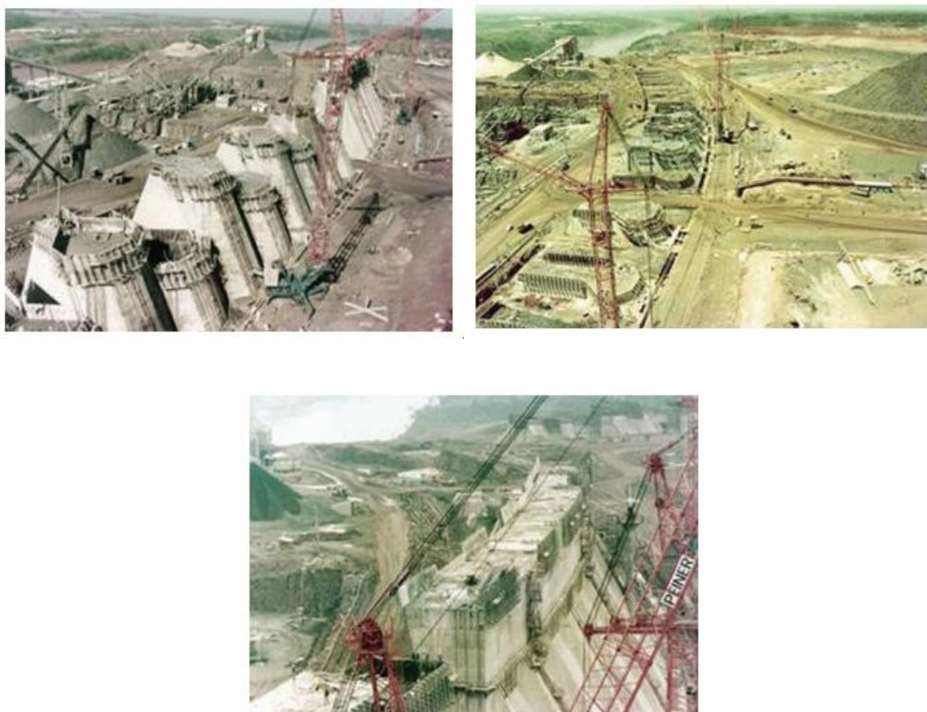
Figura 17. Construção dos blocos de contraforte – Fonte: ANDRIOLO e BETIOLI [32]
