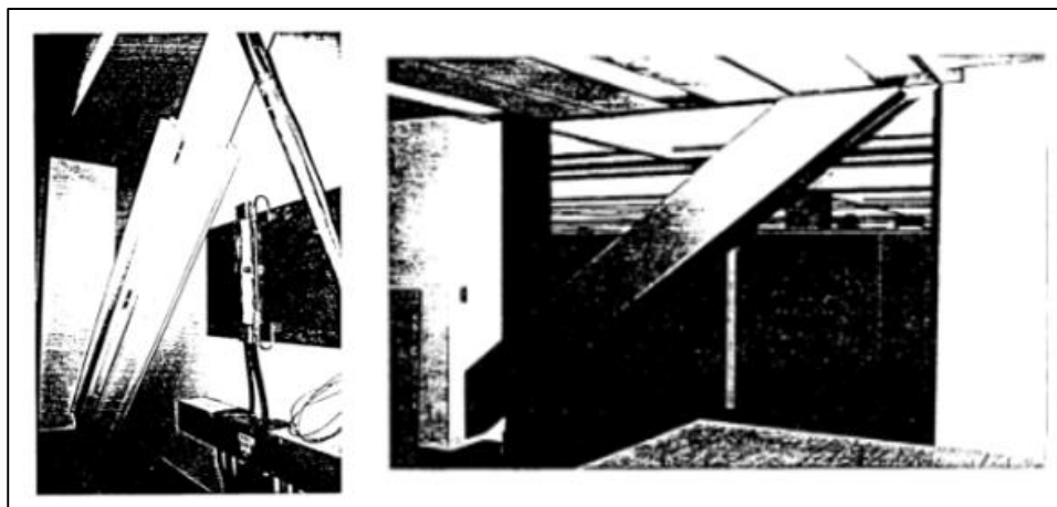
Figura 1-8. Vista geral dos amortecedores instalados no prédio Santa Clara County (BERTERO e WHITTAKER, 1989).
