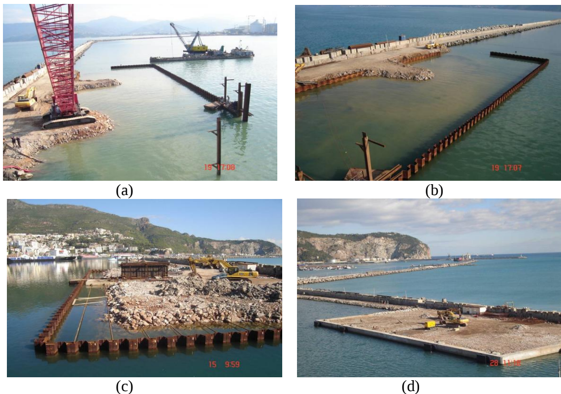
Figura 2.14. Etapas da construção do Cais Misto de Bejaia – Argélia: (a) instalação das estacas – I, (b) instalação das estacas – II, (c) aterramento e (d) conclusão da obra (ICSA, 2017).
