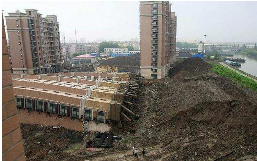
Figura 5.41 – Prédio tombado em Xangai (JI, 2010)
