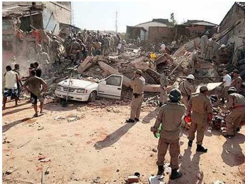
Figura 5.9 – Escombros do edifício Raimundo Farias (PORTAL ORM, 2011)
