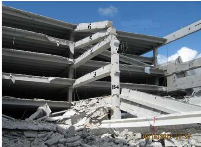
Figura 5.48 – Vigas tipo “double tee” no chão depois do desabamento do edifício-garagem na Florida (OSHA, 2013)
