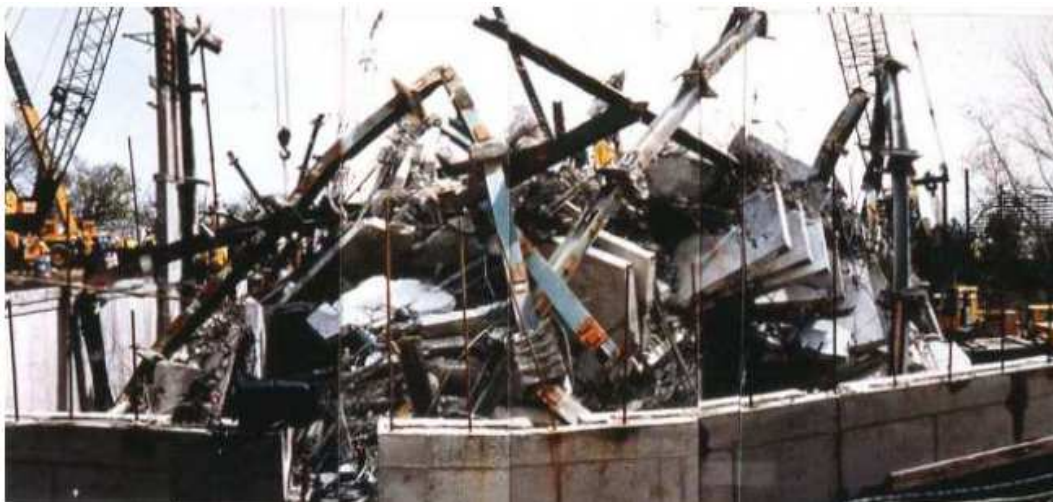
Figura 5.35 – L'Ambiance Plaza após o colapso (McNAMARA e PARFITT, 2010)
