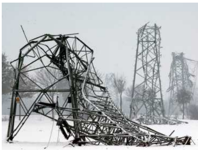
Figura 2.4 – Exemplo de colapso do tipo dominó (STAROSSEK, 2009)
