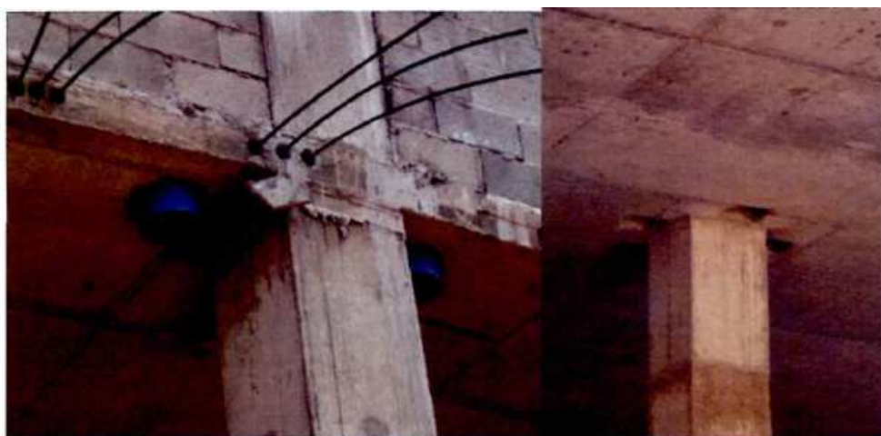
Figura 5.15 – Furos existentes nas lajes junto às faces dos pilares do Shopping Rio Poty (CREA-PI, 2013)
