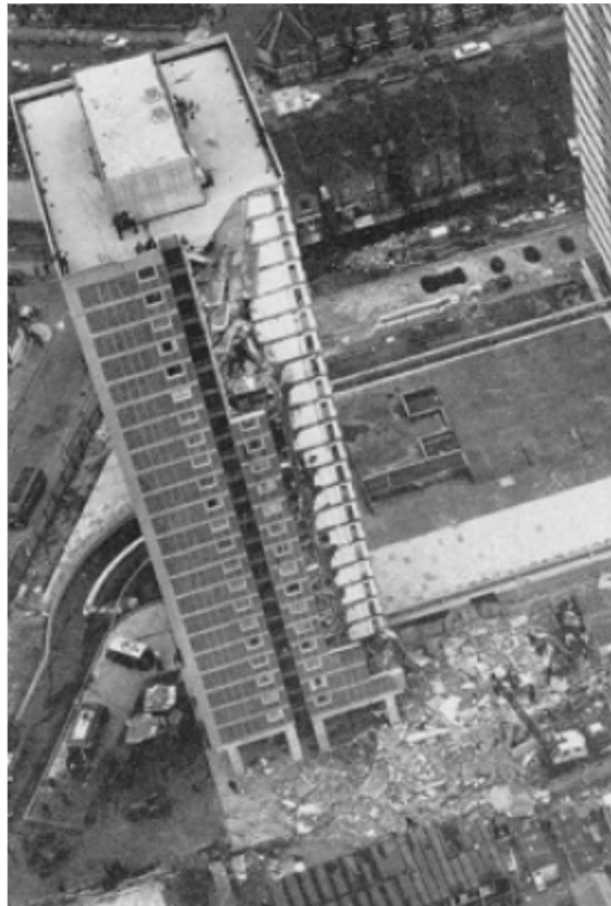
Figura 1.1 – Edifício Ronan Point após colapso parcial (CANISIUS, 2011)
