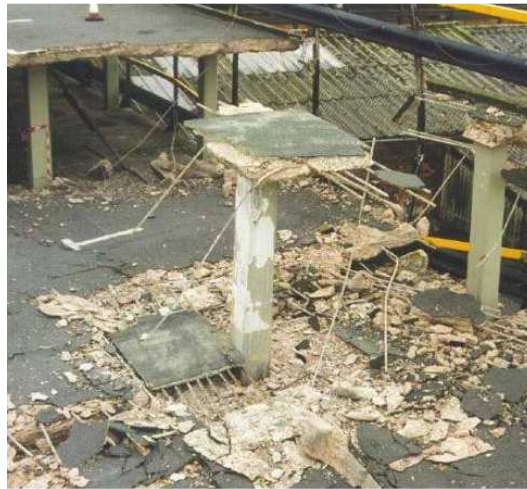
Figura 5.37 – Pilar e parte da laje intactos após o colapso do Pipers Row Car Park (WOOD, 2003)
