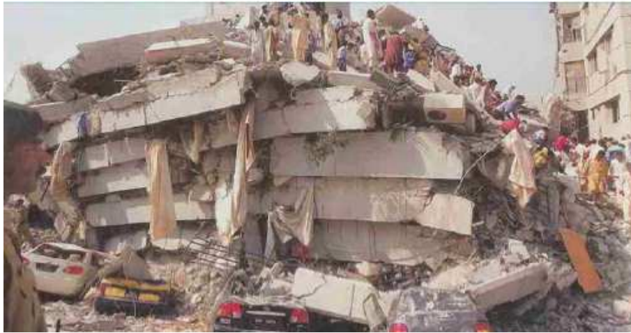
Figura 2.2 – Exemplo de colapso do tipo panqueca (STAROSSEK, 2009)
