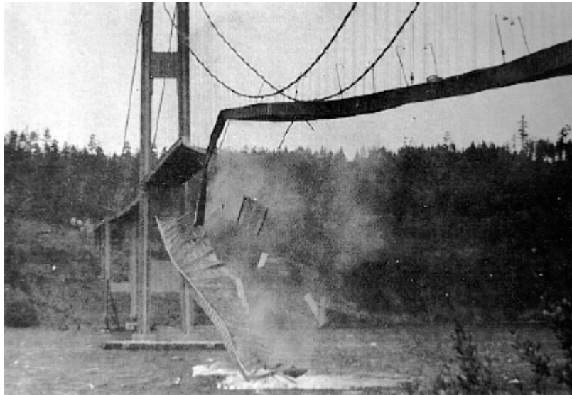
Figura 2.6 – Exemplo de colapso do tipo zíper (STAROSSEK, 2009)
