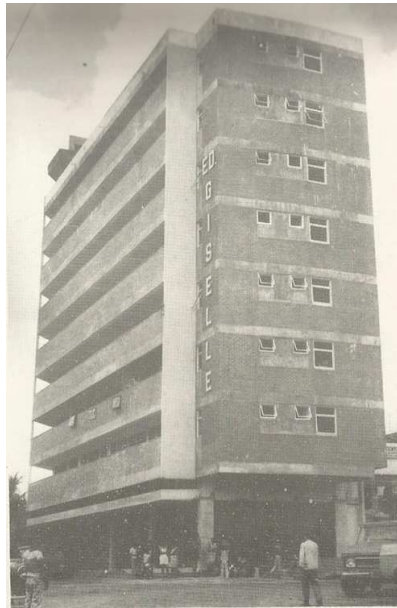
Figura 5.21 – Edifício Giselle ainda em construção (JABOATÃO ANTIGO, 2014)
