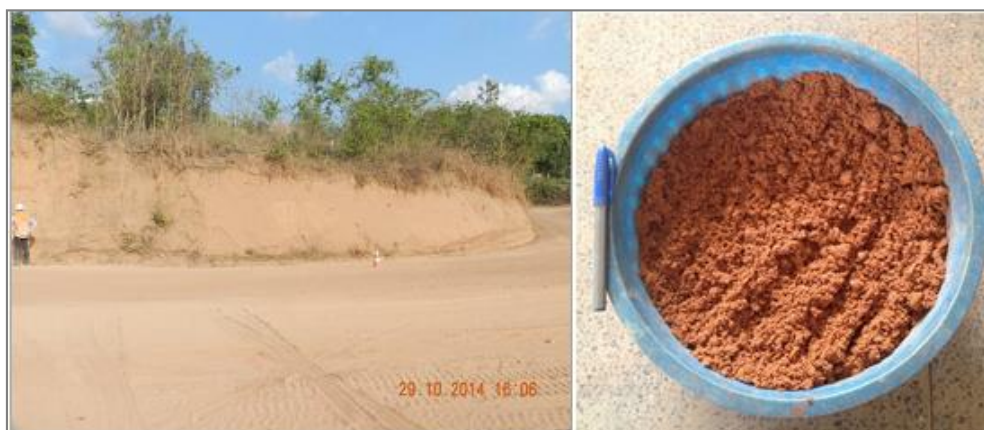
Fig. 3.4. (a) Aspecto do talude de origem da amostra LA (GUIMARÃES & SANTANA, 2014). (b) Material pronto para ensaio.
