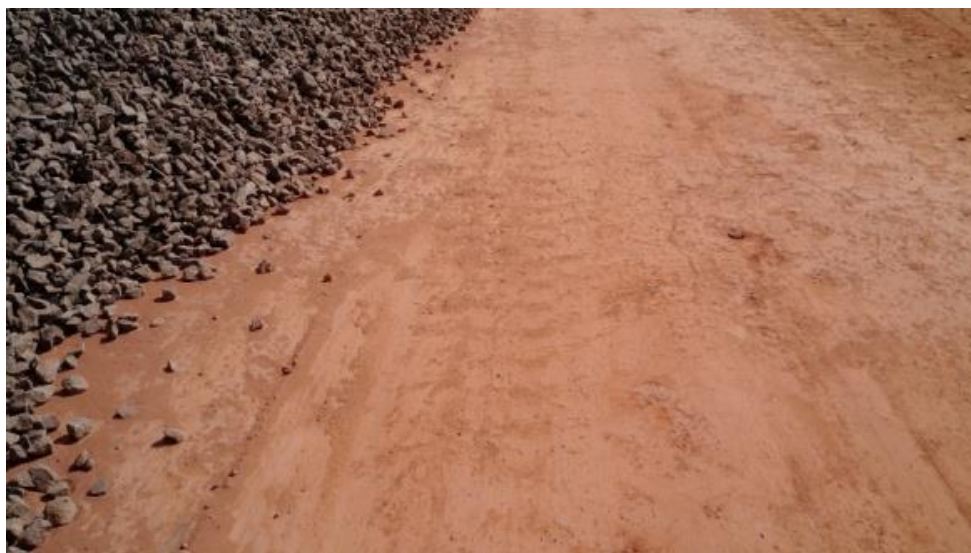
Fig. 2.3. Aspecto da camada de sublastro executada com SAFL. (SILVA FILHO et al. , 2018)
