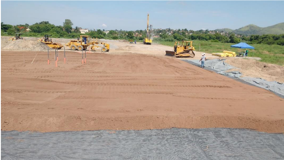
Figura 3.9 – Execução da camada drenante de 0,40 m
