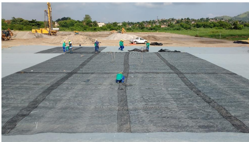
Figura 3.7 – Instalação geotêxtil e geogrelha
