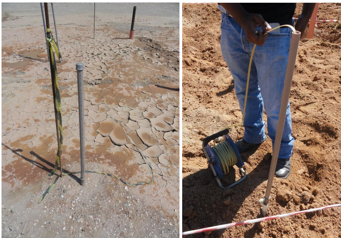
Figura 3.22 – Acompanhamento da leitura dos piezômetros
