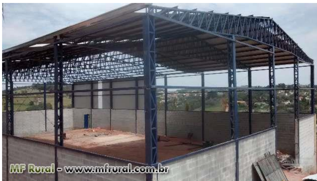
Figura 1.4 – Galpão construído em aço constituído de perfis formados a frio (MFRURAL)
