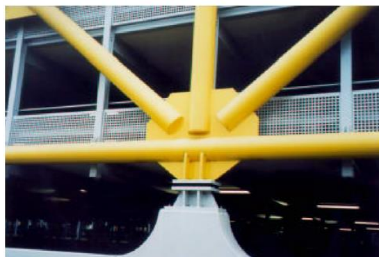
Figura 41 – Ligação com placa Gusset (Santos, 2003)
