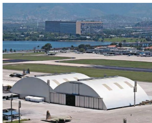
Figura 27 – Hangar da Base Aérea do Galeão (Construção Metálica, 2009)
