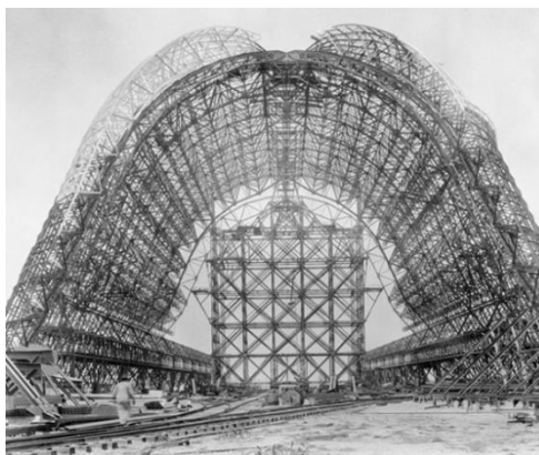
Figura 23 – Hangar do Dirigível USS Macon, Califórnia, EUA (Hangar 33, 2015)
