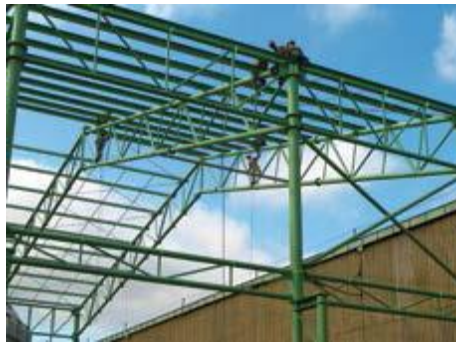
Figura 37 – Galpão Valourec Minas Gerais (Araújo et al. , 2016)
