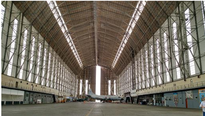
Figura 1 - Hangar do Zeppelin, Base Aérea de Santa Cruz, RJ
