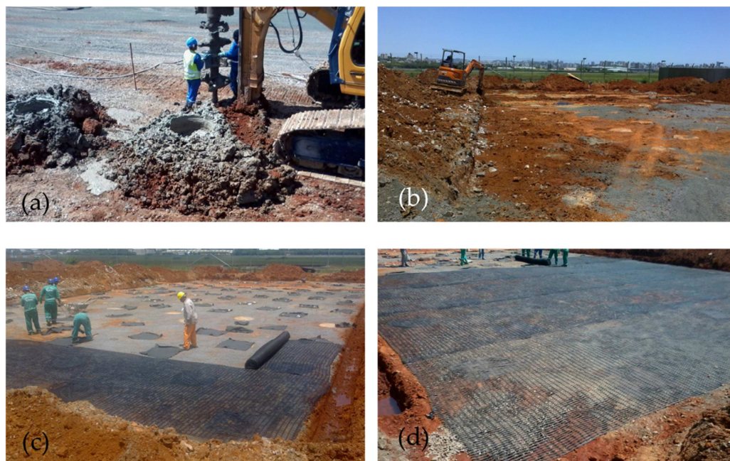
Figura 3.19 – Processo executivo: (a) Término da execução de uma coluna de DSM ; (b) Limpeza após execução das colunas;. (c) Instalação da geogrelha sobre as colunas protegidas com geotêxtil; (d) Instalação da geogrelha.
