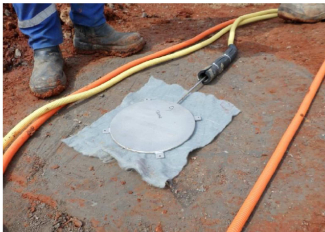
Figura 3.26 – Instalação da célula de tensão total sobre a coluna sob a geogrelha.
