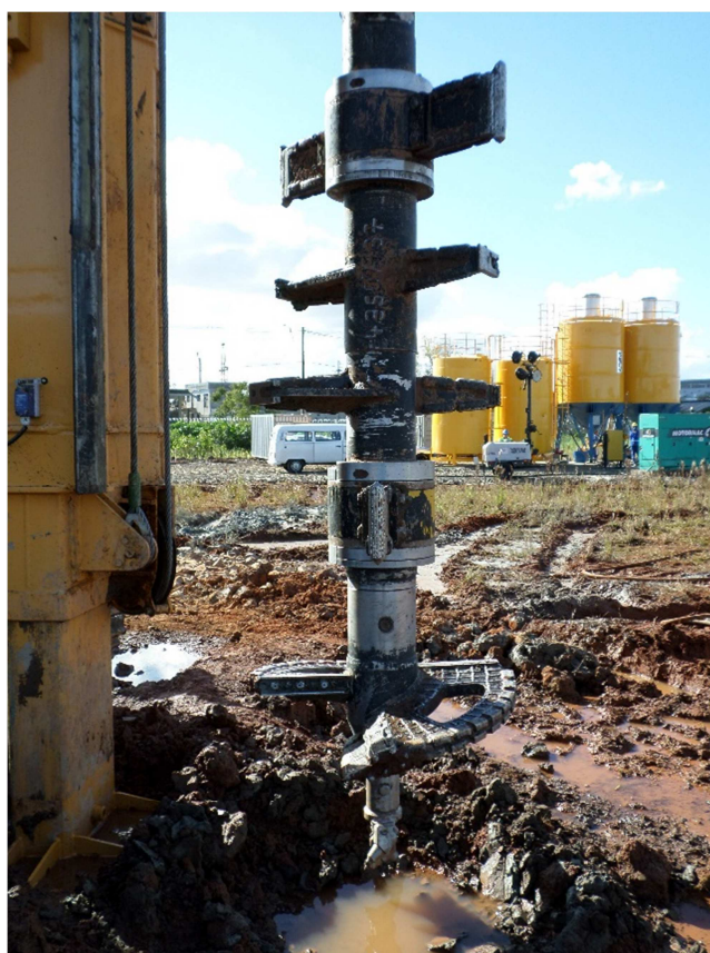
Figura 3.18 – Detalhe da ferramenta de mistura.
