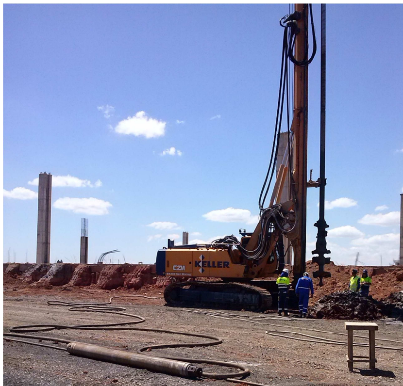
Figura 3.17 – Equipamento para execução da coluna DSM .
