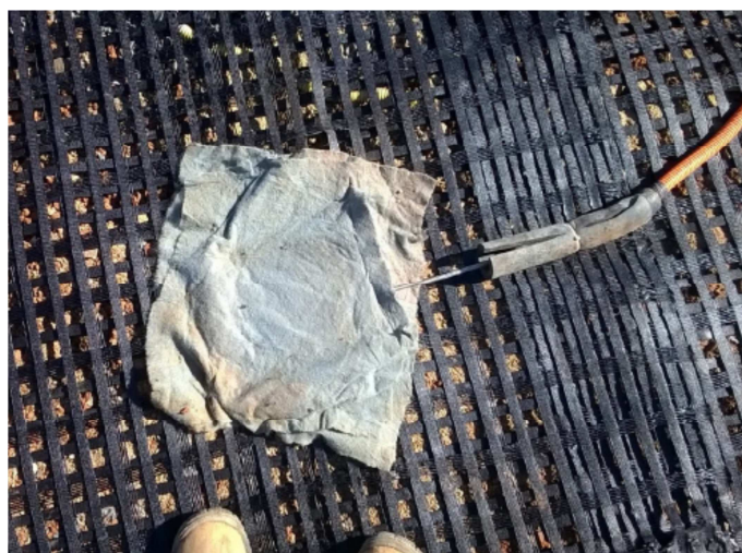
Figura 3.27 – Instalação da célula de tensão total sobre a geogrelha.
