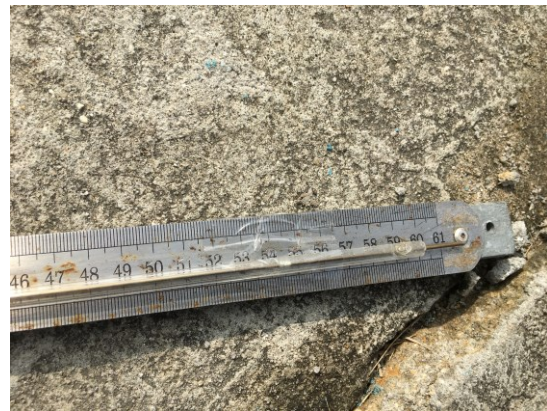
Figura 4.52 – Régua do Medidor de nível.
