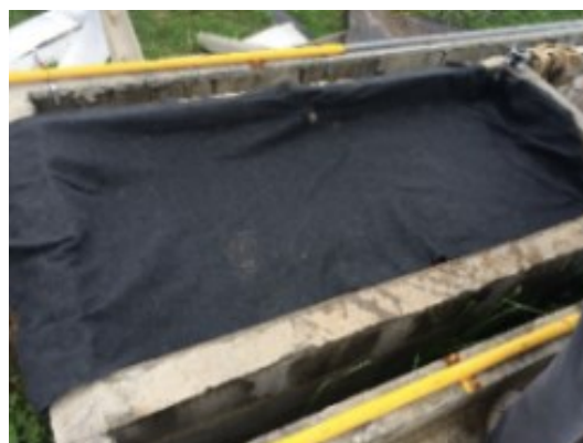
Figura 4.15 – Manta bidim colocada no módulo, abrangendo as paredes das faces.
