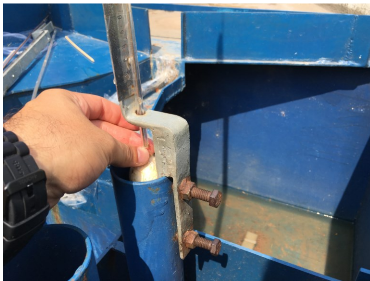
Figura 4.53 – Aparato para medição de nível dentro do tubo piezométrico, destacando os parafusos como mecanismo de prisão.
