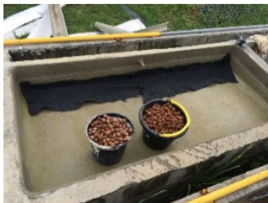
Figura 4.11 – Colocação da manta bidim para proteger os tubos de drenagem.
