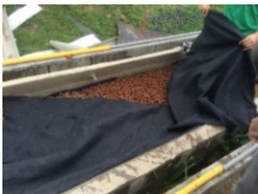
Figura 4.14 – Processo de colocação da manta bidim sobre a camada drenante.
