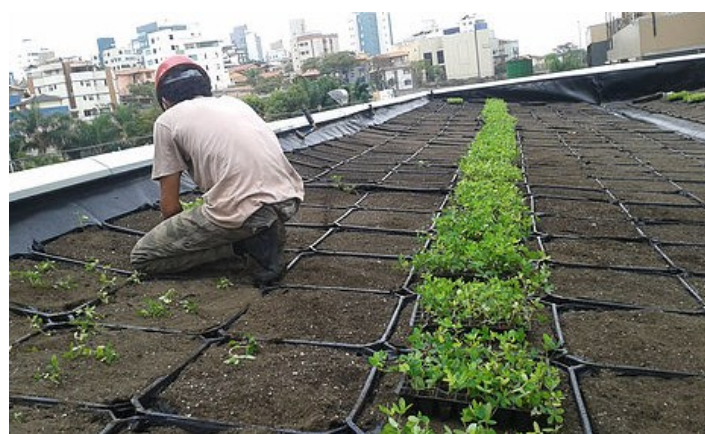
Figura 3.40 – Aplicação do sistema modular em uma cobertura.
