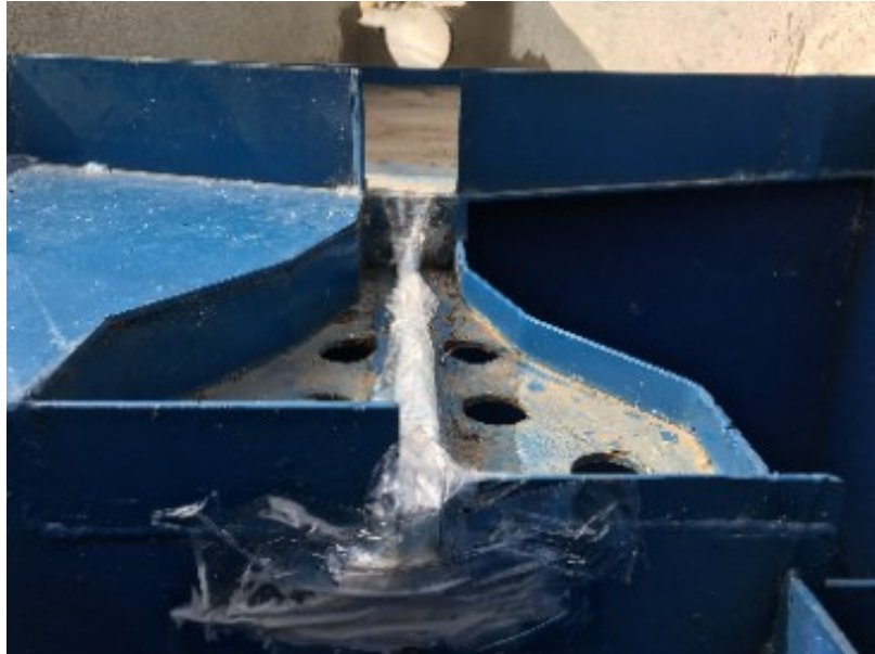
Figura 4.54 – Obstrução da entrada de água no reservatório pequeno com fita.
