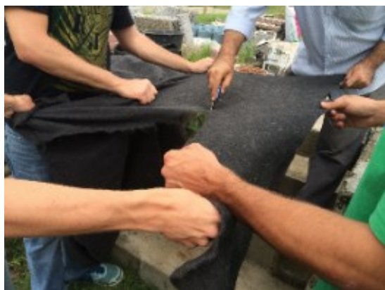
Figura 4.10 – Recorte da manta bidim para obter o tamanho necessário.
