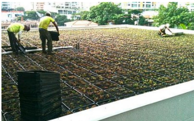
Figura 1.10 – Telhado verde composto por placas modulares (Sistema Modular da empresa Studio Cidade Jardim).
