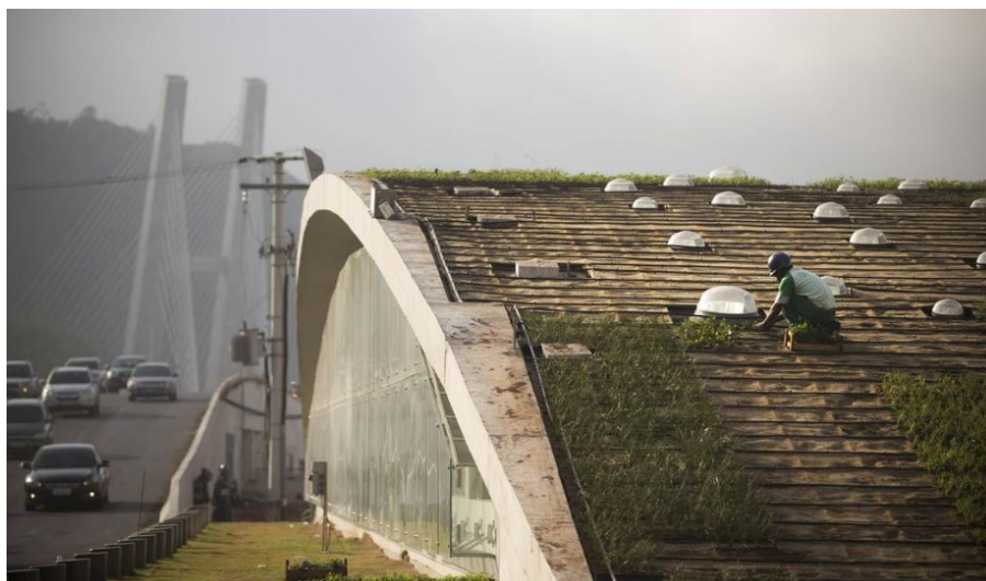
Figura 3.35 – Estação Jardim Oceânico (Linha 4 do metrô), na cidade do Rio de Janeiro.
