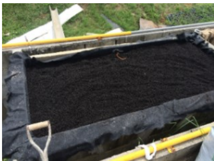
Figura 4.22 – Protótipo de telhado verde, após lançamento da camada de substrato.
