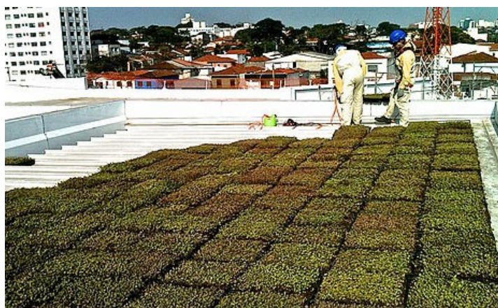
Figura 3.39 – Aplicação do sistema modular em uma cobertura.
