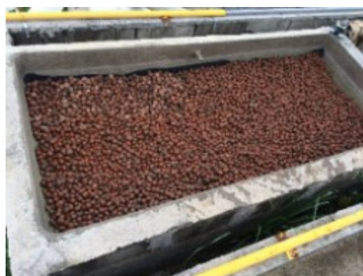
Figura 4.13 – Camada de drenagem executada.
