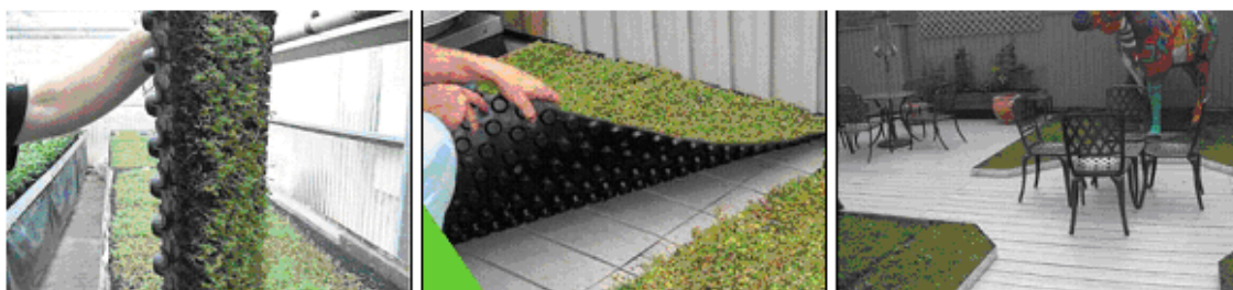
Figura 3.41 – Sistema da manta pré-cultivada aplicada em uma cobertura residencial.
