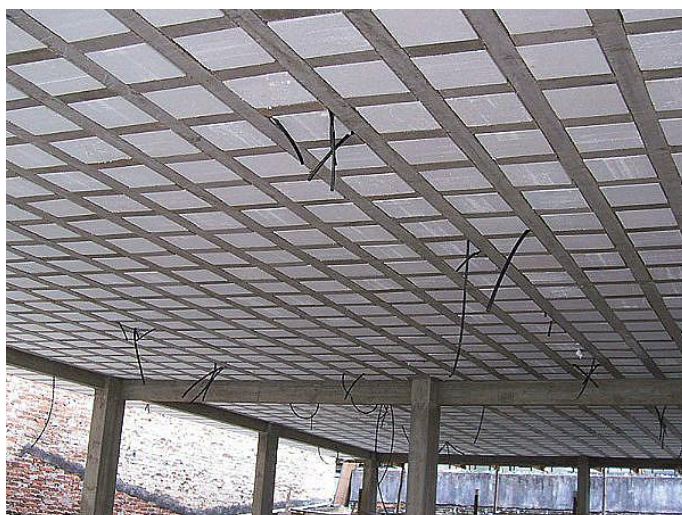
Figura 2.2 – Laje nervurada com blocos de EPS como material de preenchimento (Disponível em: < http://www.cimentoitambe.com.br/eps-amplia-desempenho-termoacustico-do-concreto/ > Acesso em 27 de maio de 2015)
