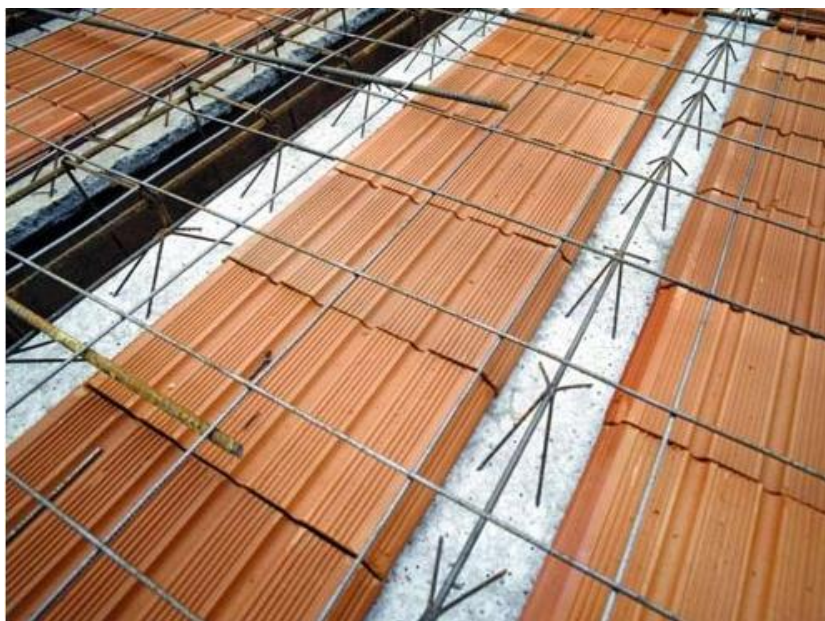
Figura 2.4 – Laje com nervuras treliçadas pré-moldadas e bloco cerâmico
