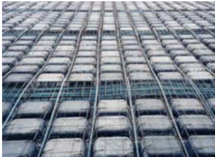
Figura 2.3 – Moldes plásticos reaproveitáveis em laje nervurada protendida (Disponível em: < http://www.atex.com.br/LajeNervurada > Acesso em 27 maio de 2015)
