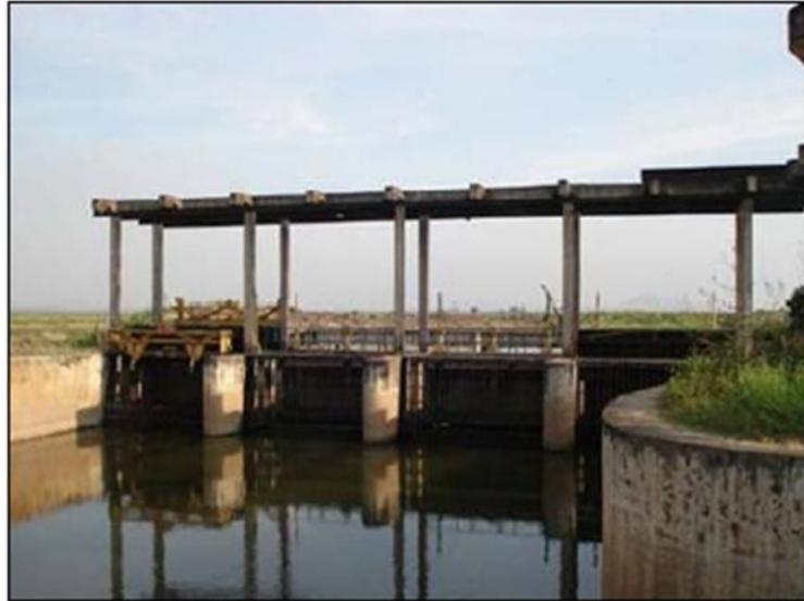
Figura 5.2: Entradas na captação de água. Fonte: CONCREMAT, 2007
