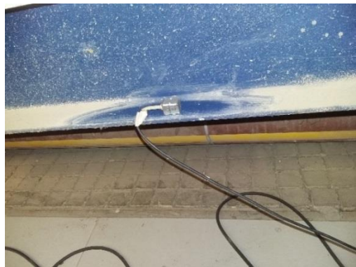
Figura 3.4: Detalhe de fixação do acelerômetro à estrutura
