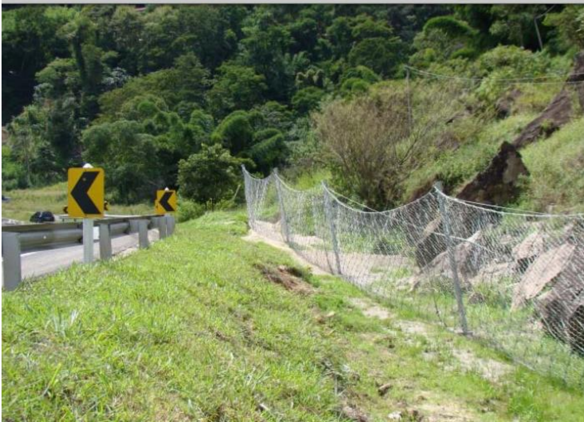
Figura 2.13 – Barreira flexível – BR040 – RJ (NUNES, 2013).
