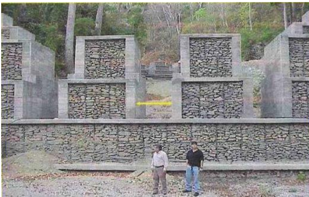
Figura 2.9 – Barreiras permeáveis para mitigação de fluxo de detritos – Parque Waraira Reparo (Ávila) – Caracas, Venezuela.
