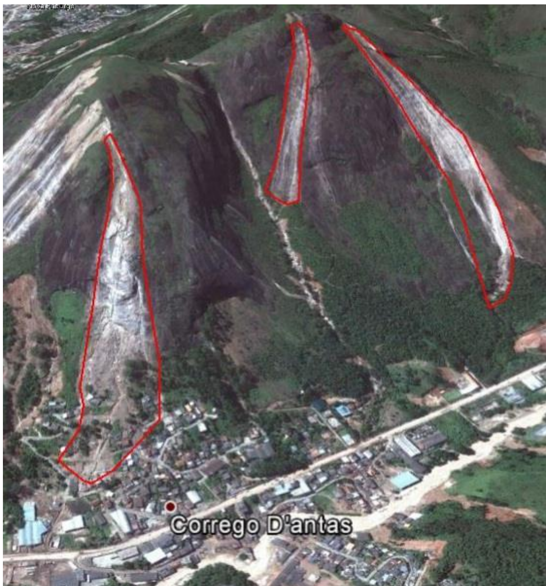
Figura 4.14 – Condição da área após o Evento Córrego D'Antas, Julho de 2010 (GOOGLE EARTH, 2010)
