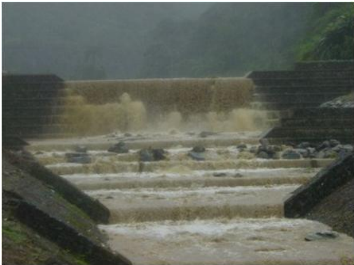
Figura 2.14 – Bermas dissipadoras de energia, La Guaira , Venezuela (1996).
