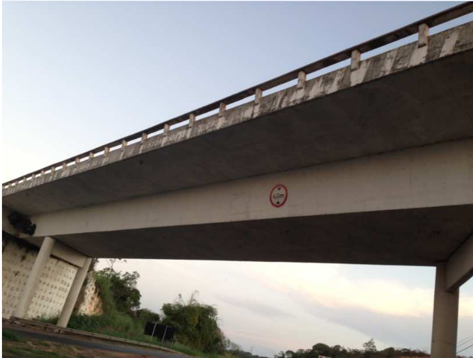
Figura 3.19 – Viaduto sobre a BR-324
