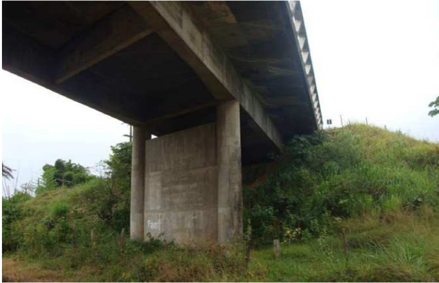
Figura 3.33 – Ponte sobre a linha férrea na BA-524/Km-19 (adaptado de CONTROLLATO, 2010b)
