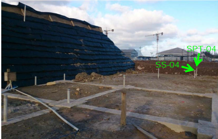
Figura 3.45 Fotografia da obra em 15/08/13 (Geoconsult)
