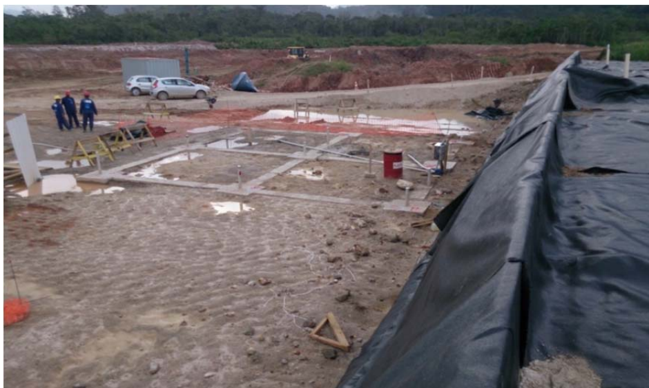
Figura 3.44 Fotografia da obra em 03/07/13 (Geoconsult)
