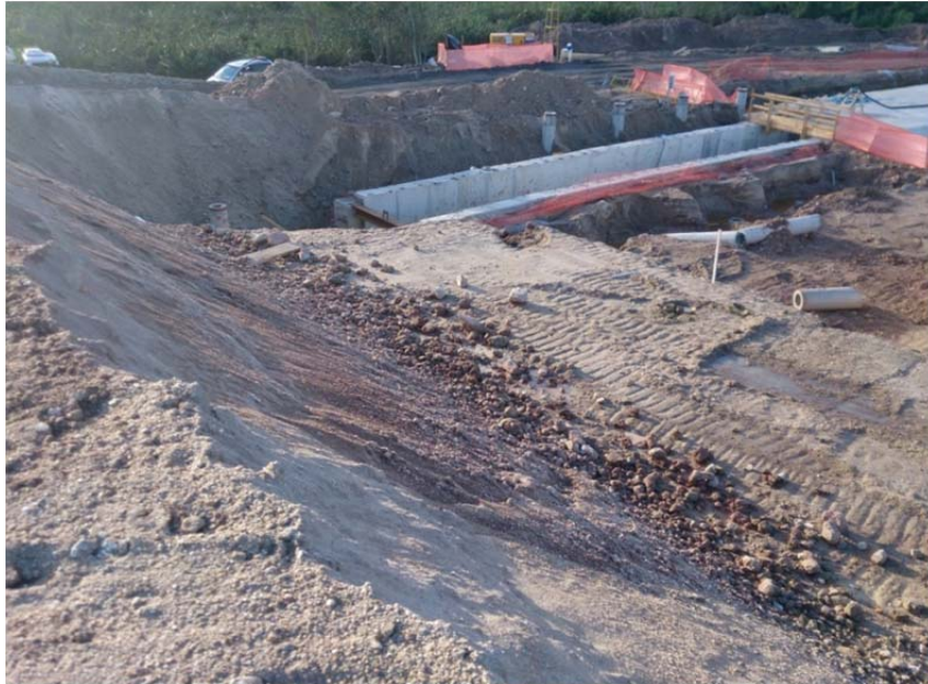
Figura 3.48 Fotografia da obra em 15/08/13 (Geoconsult)
