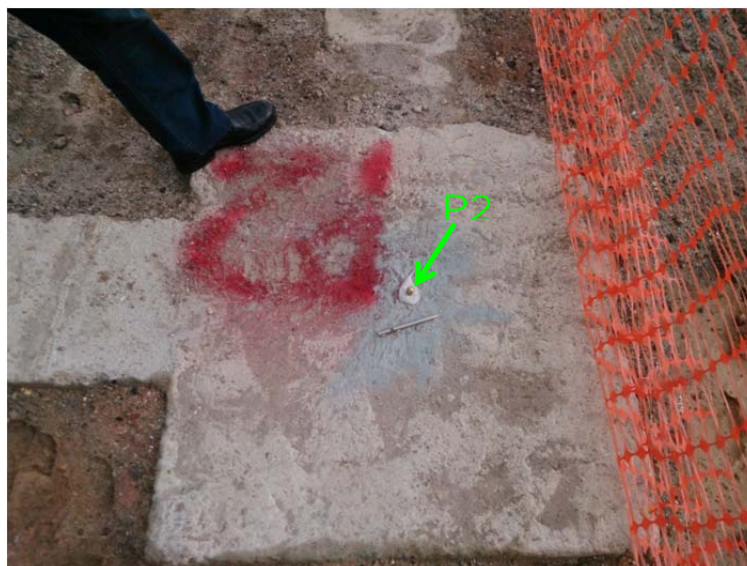
Figura 3.29 Pino de recalque P2 no bloco da estaca E-05 (Geoconsult)
