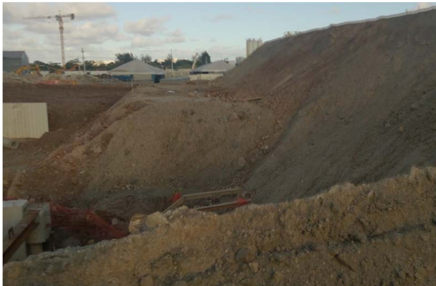
Figura 3.49 Fotografia da obra em 15/08/13 (Geoconsult)
