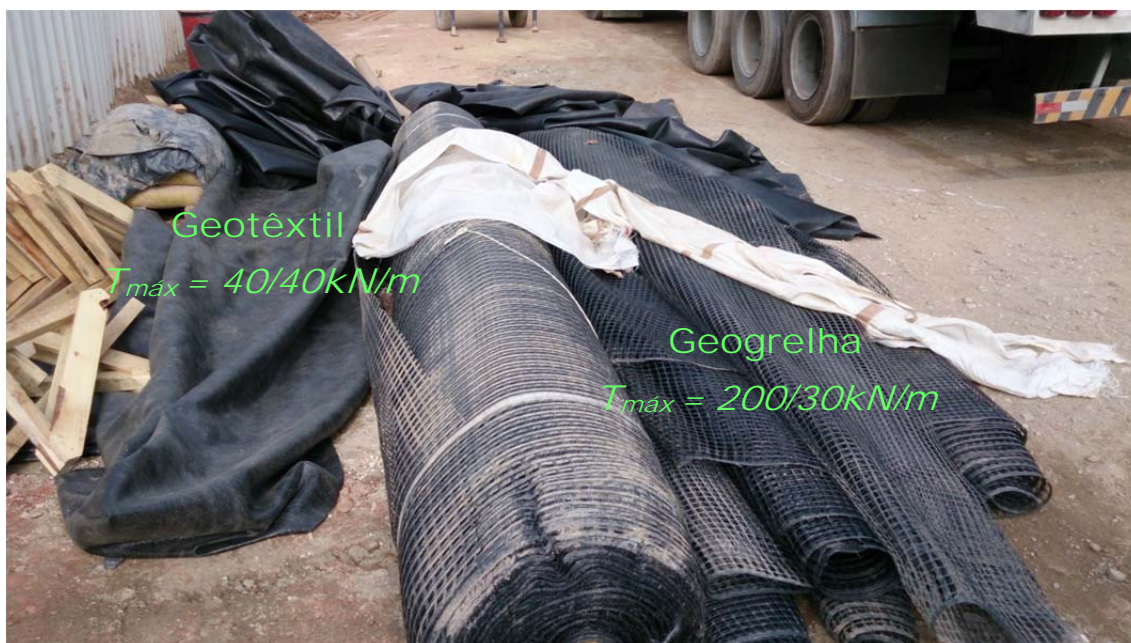
Figura 3.13 Geogrelha utilizada sob o aterro e geotêxtil utilizado no envelopamento do talude ( Geoconsult )
