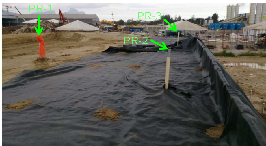
Figura 3.22 Posicionamento das placas de recalque - 4º alteamento (Geoconsult)
