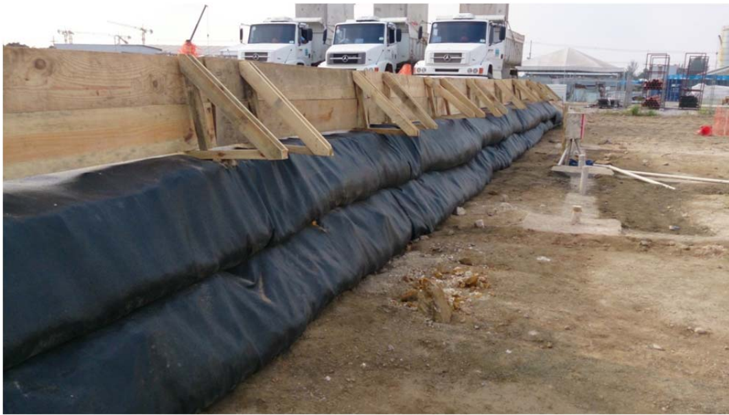
Figura 3.15 Envolvimento do talude junto ao estaqueamento ( Geoconsult )
