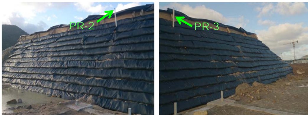
Figura 3.23 Hastes das placas PR-2 e PR-3 interceptando o talude ( Geoconsult )
