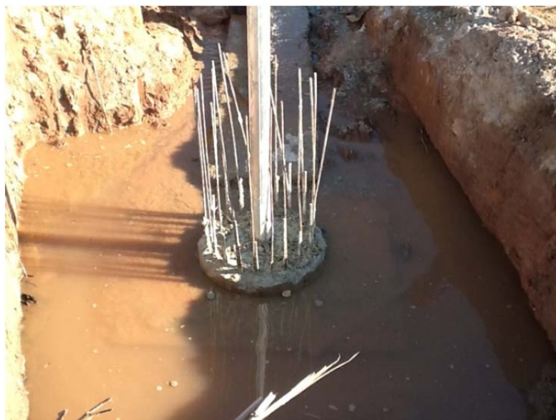
Figura 3.28 Tubo IV-11 instalado no interior da estaca E-12 (Geoconsult)
