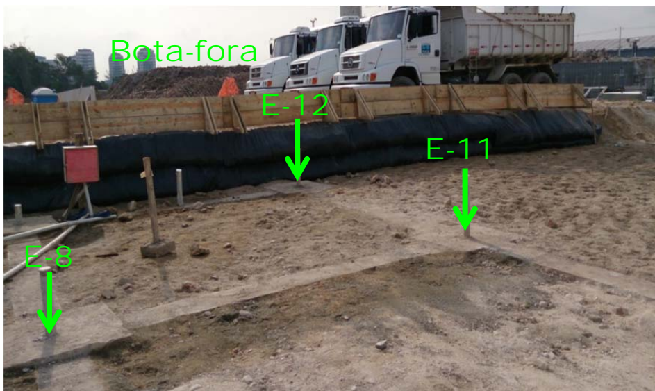
Figura 3.41 Fotografia da obra em 13/06/13 (Geoconsult)
