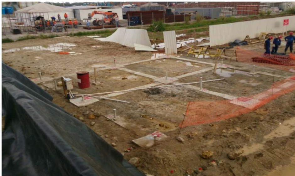
Figura 3.43 Fotografia da obra em 03/07/13 (Geoconsult)
