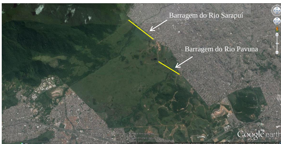
Figura 7.20: Barragem de Gericinó. Fonte: Adaptado do Google Earth (2015).
