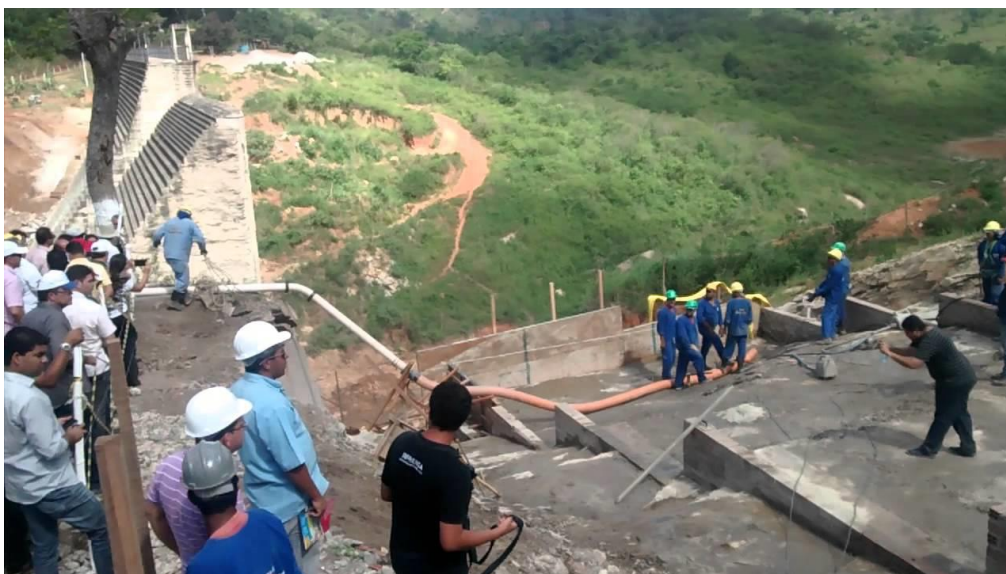
Figura 7.22: Construção da Barragem do Rio Pavuna – 1990 – 1993. Fonte: SONDOTÉCNICA 1990-1993 “Barragem do Rio Pavuna – Serla”.
