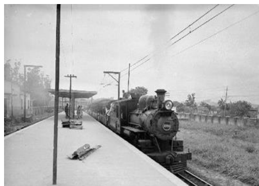
Figura 7.8: Estação de Coelho da Rocha na década de 50 Fonte: Bairro Grande Rio (1950).
