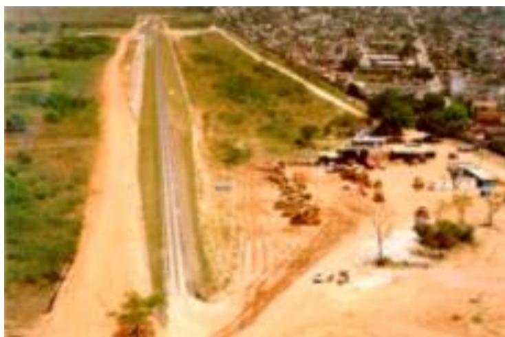
Figura 7.21: Construção da Barragem do Rio Pavuna – 1990 – 1993. Fonte: SONDOTÉCNICA 1990-1993 “Barragem do Rio Pavuna – Serla”.
