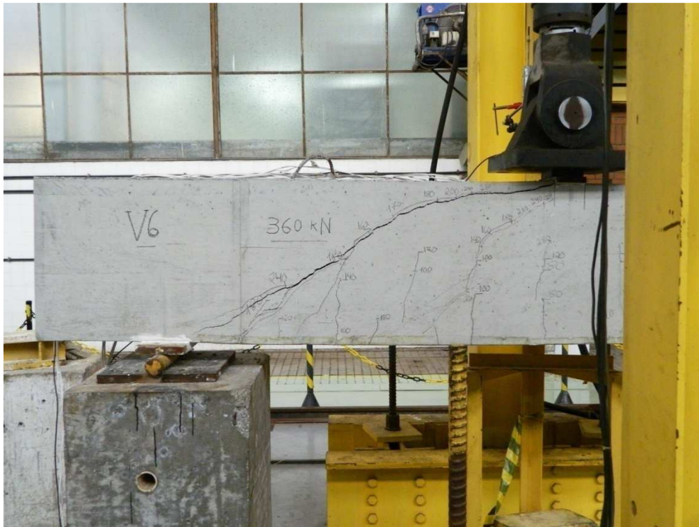
Figura 3.16 – Aspecto pós-ruptura da viga V6 ( F_u=360\text{kN} ).
