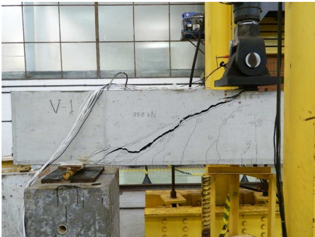
Figura 3.17 – Aspecto pós-ruptura da viga V1 ( F_u=358\text{kN} ).
