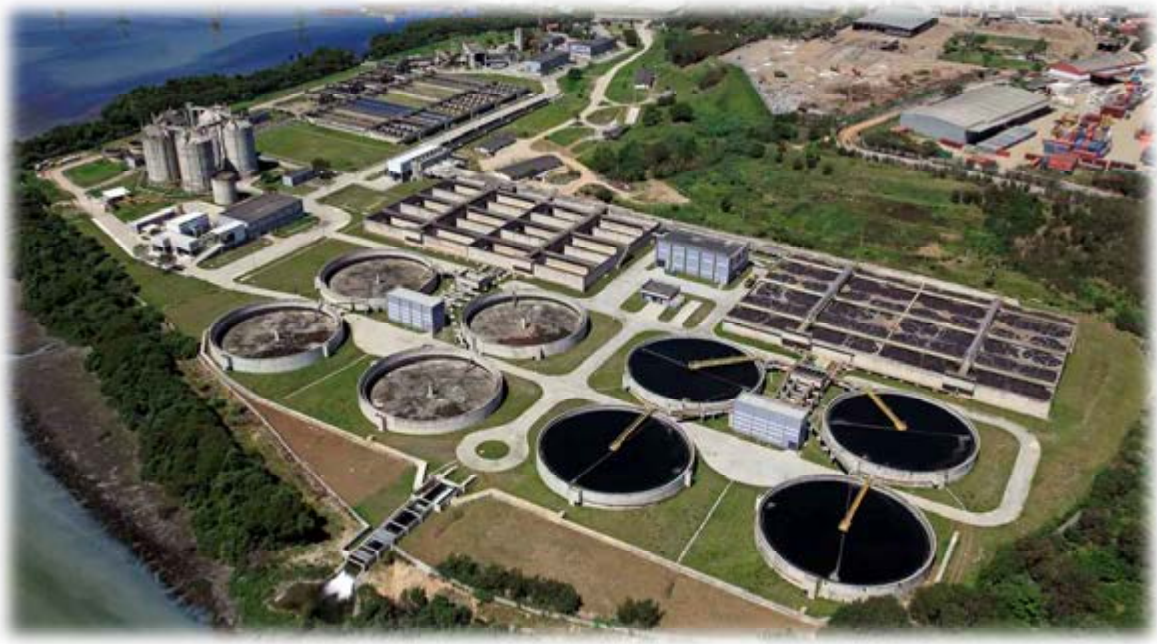
Figura3.8: Imagem panorâmica da ETE Alegria (CÁPUA ENGENHARIA, 2013)
