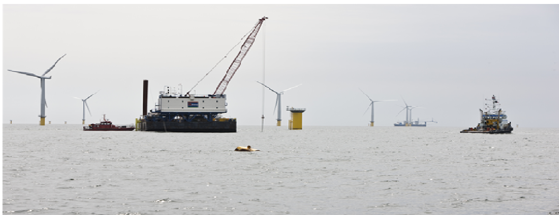
Figura 1-2 – Instalação das turbinas em Horns Rev 2, maior campo de energia eólica instalado em águas do mundo (Dong Energy, 2009)
