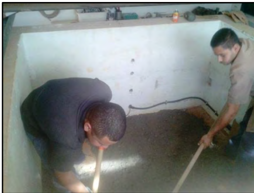
Espalhamento do material
