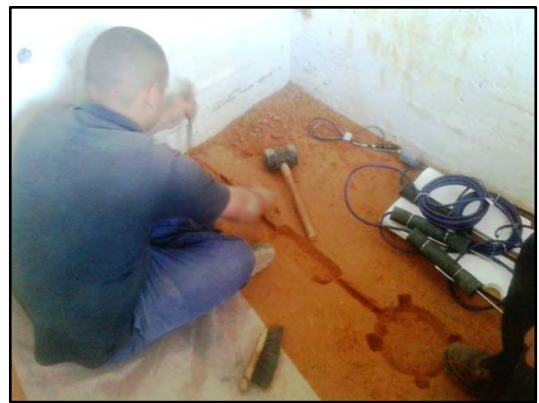
Trincheira para instalação da Célula de pressão
