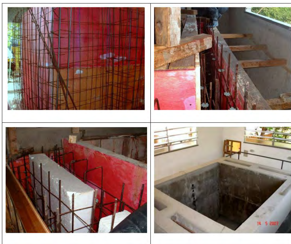
Figura 2.15: Etapas da construção do "Tanque-Teste" (SILVA, 2009)
