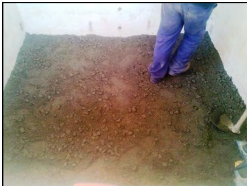
Espalhamento do material
