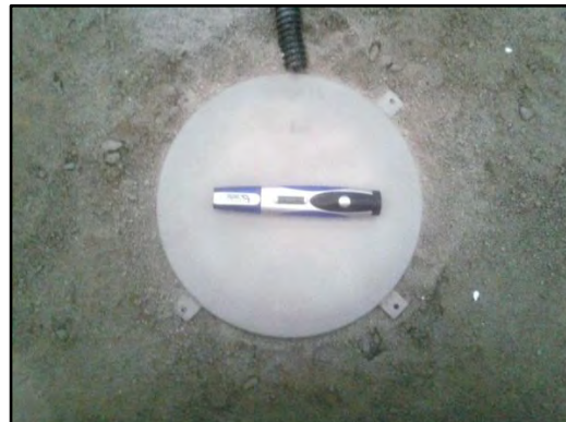
Nivelamento da célula de pressão
