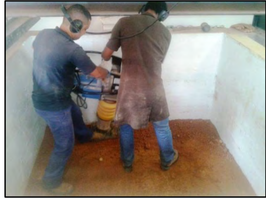
Compactação do subleito
