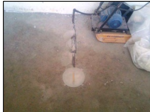
Sub-base pronta para colocação da Base
