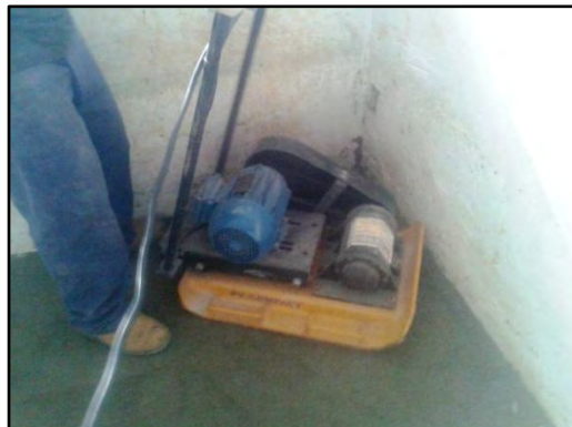
Compactação com placa vibratória
