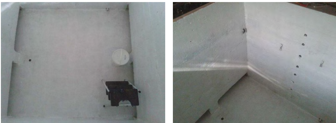
Figura 3.16: Impermeabilização do Tanque-Teste usado nesta dissertação
