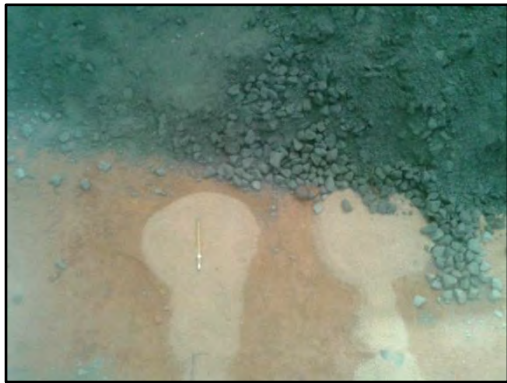
Espalhamento da BGS sobre as células
