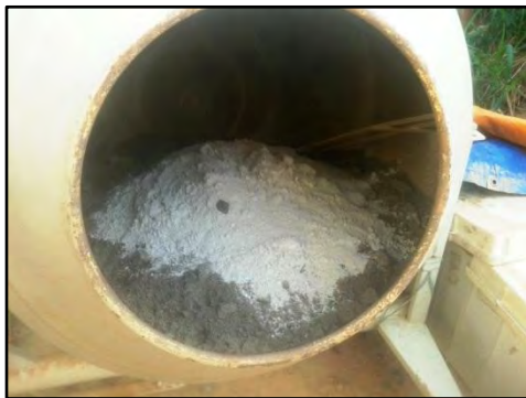
Mistura do material com cimento
