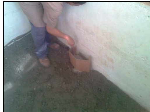
Instalação da célula da parede
