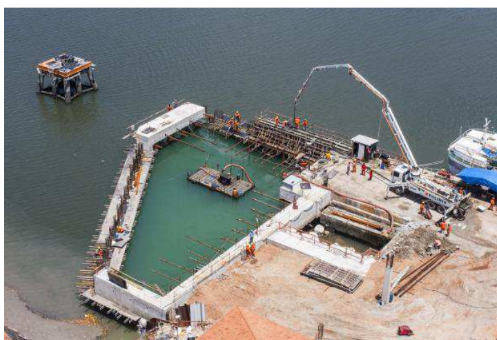
Figura 2.8 – Vista aérea das obras de ampliação do terminal marítimo do Rio Grande do Norte - terminal de passageiros. Em detalhe a concretagem da viga de capeamento da cortina de estacas prancha - fonte: http://copatransparente.gov.br
