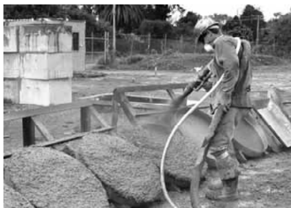
Figura 2.3 – Moldagem manual de painéis utilizando concreto projetado. (Fonte: ASTM C1550, 2005).
