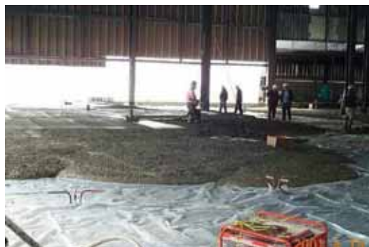
(a) Instalação de uma G-SFRES ( Ground elevated steel fiber reinforced slabs ).
