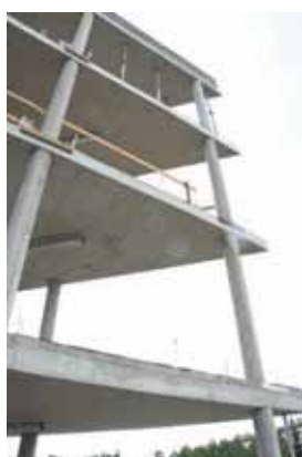
(b) Imagens de construções e aplicações de E-SFRES ( Elevated fiber reinforced slabs ).
