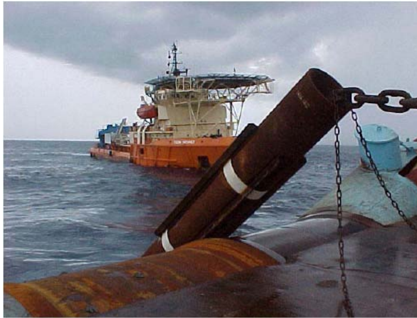
Figura 22 - Lançamento de estaca torpedo para ancoragem de riser [11]
