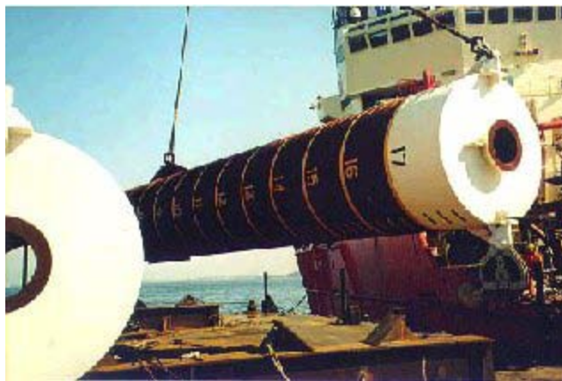
Figura 14 - Estaca de sucção [8]
