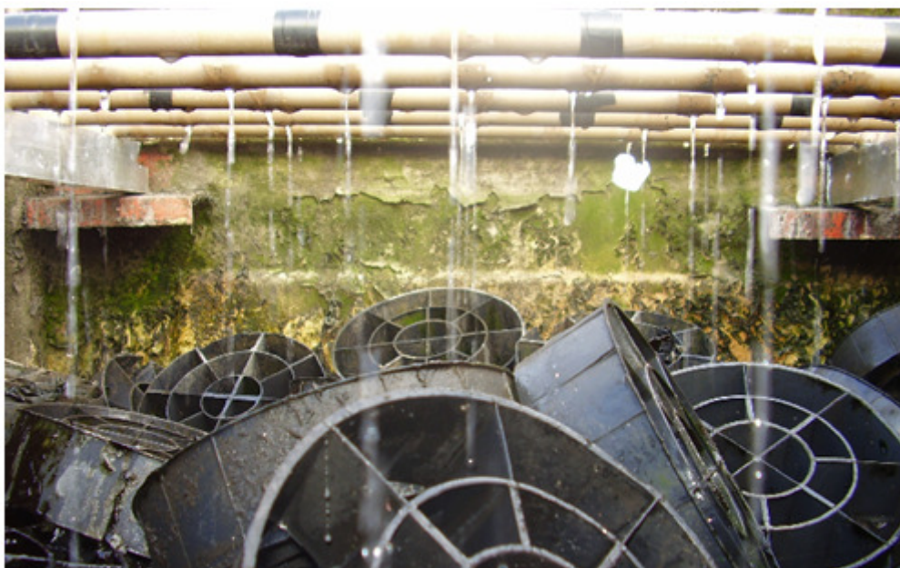
Figura 31 - Sistema de distribuição do FBP em funcionamento
