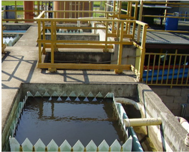
Figura 34- Decantador secundário do FBP
