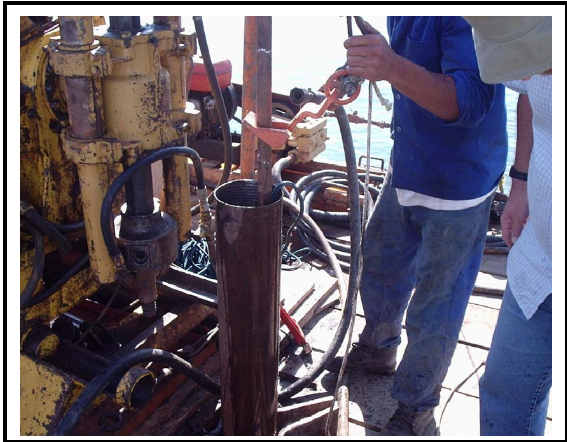
Figura D.3: Tubo de revestimento e avanço do furo por lavagem com trépano
