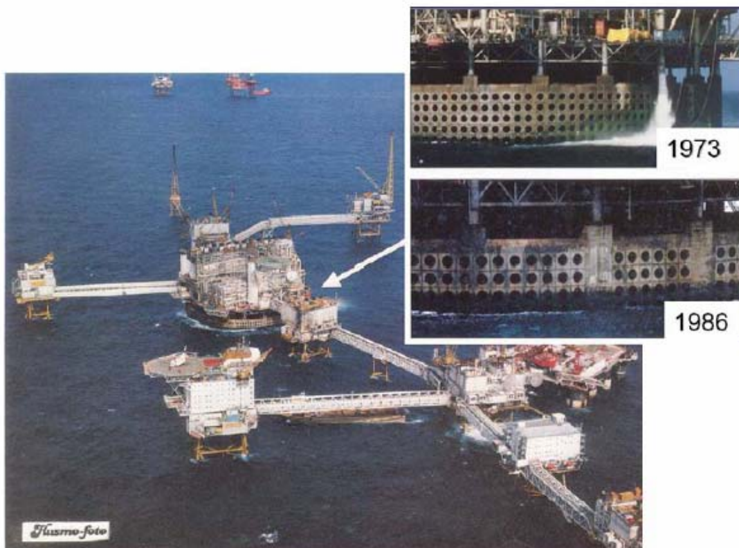
Figura 1.3 - Subsidência no campo de Ekofisk.
