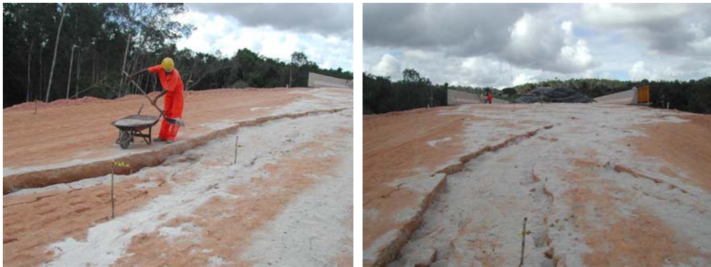
Figura 3.32- Finalizando o preenchimento de trincas com areia.
