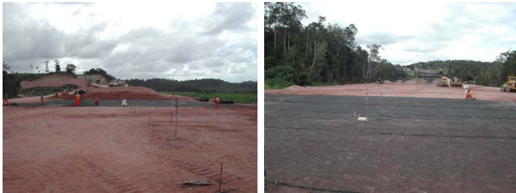
Figura 3.26-Instalação da geogrelha na área do rio João de Tiba.
