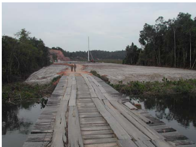
Figura 4.1– Estrada de serviço (área do rio João de Tiba).
