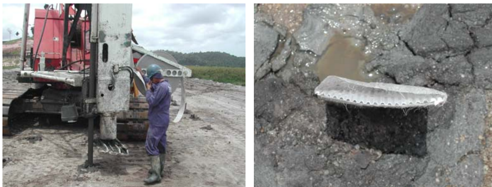
Figuras 3.14 - Detalhe do processo de cravação e do tipo de dreno pré-fabricado utilizado na área do rio João de Tiba.
