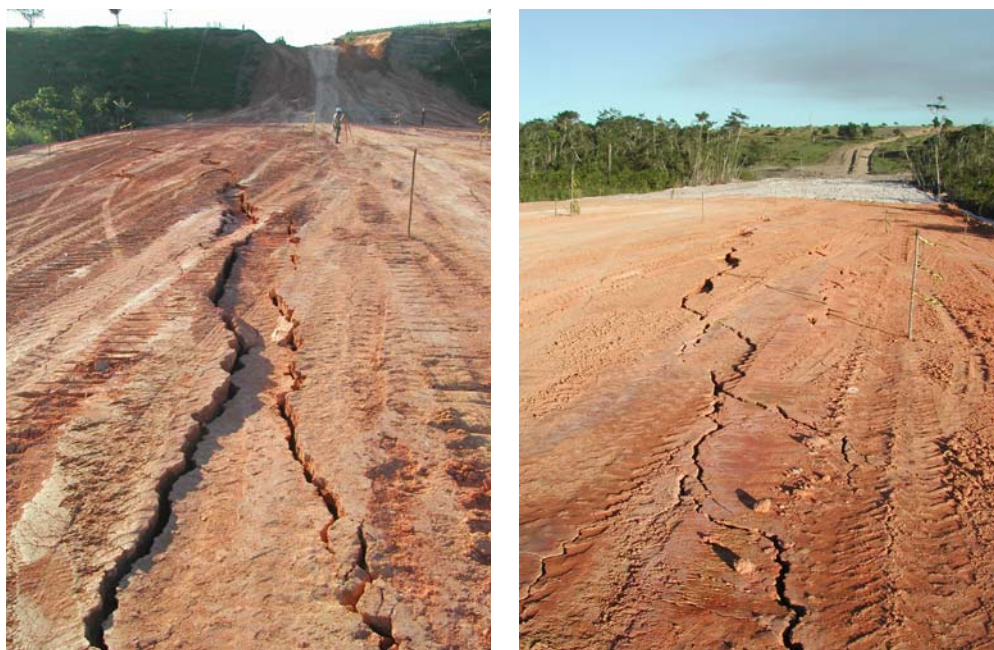
Figura 3.21- Evolução das primeiras rupturas no trecho do rio Camurugi.
