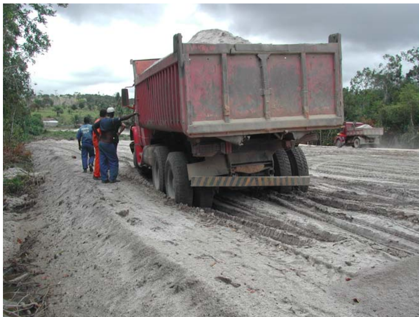
Figura 3.11 - Execução de camada drenante na área do rio João de Tiba.
