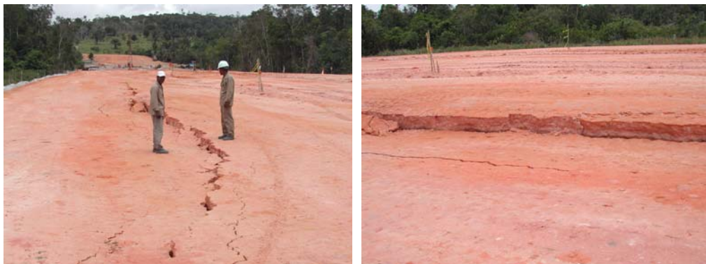
Figura 3.18 – Evolução da ruptura no trecho do rio João de Tiba
