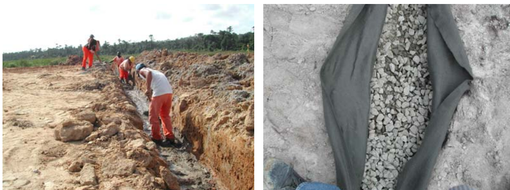
Figura 3.19- Execução dos drenos tipo “charutos” na área do rio João de Tiba.
