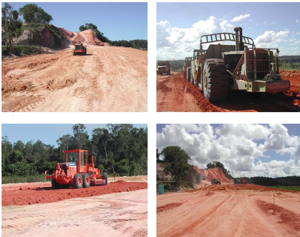
Figura 3.16- Construção do aterro na área do rio João de Tiba.
