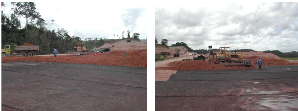
Figura 3.27- Cobertura com material sobre a geogrelha na área do rio João de Tiba - 06/08/06.
