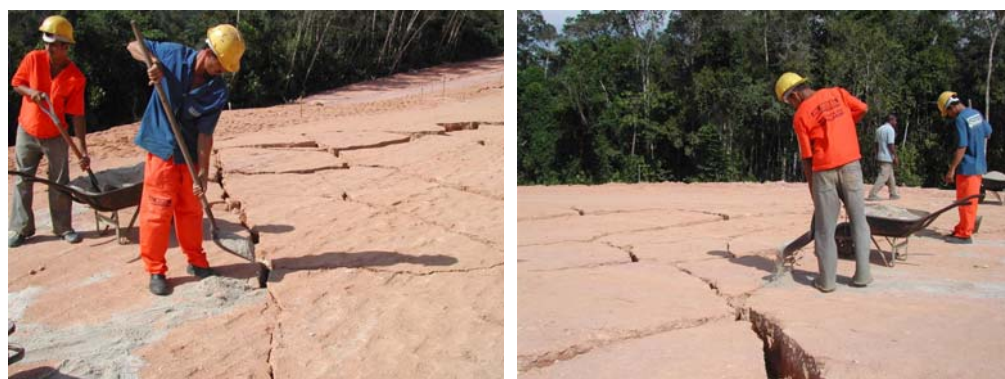
Figura 3.31- Preenchimento de trincas com areia.
