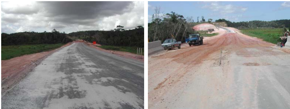
Figura 3.33- Rodovia sendo pavimentada –trecho do rio João de Tiba.
