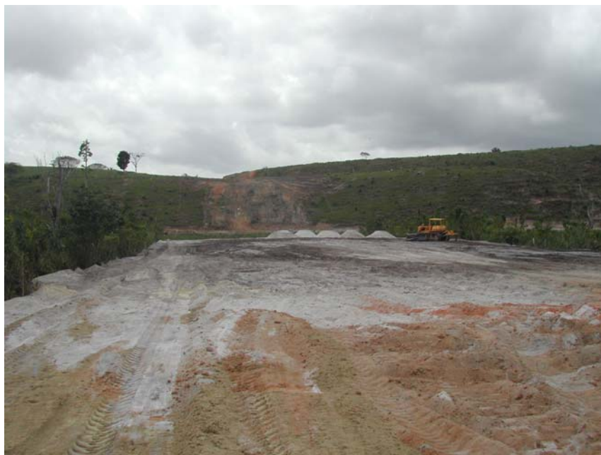
Figura 3.12- Execução de camada drenante na área do rio Camuruji.
