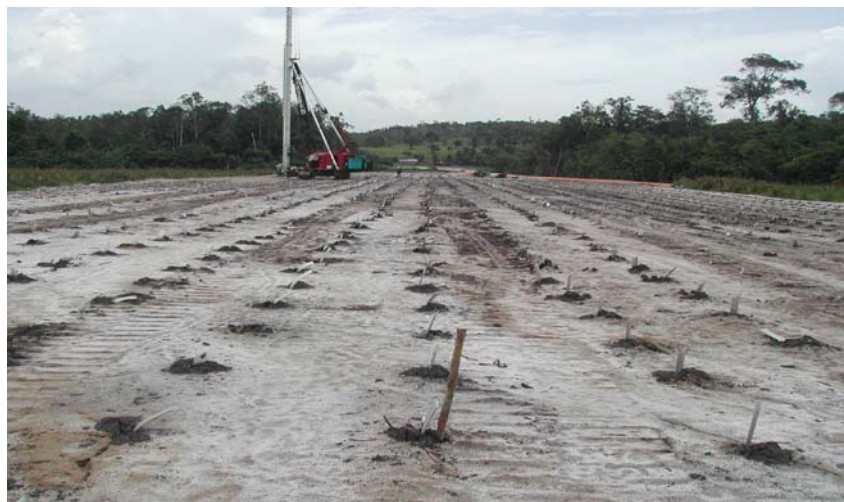
Figura 3.13 – Cravação de drenos pré-fabricados na área do rio João de Tiba.
