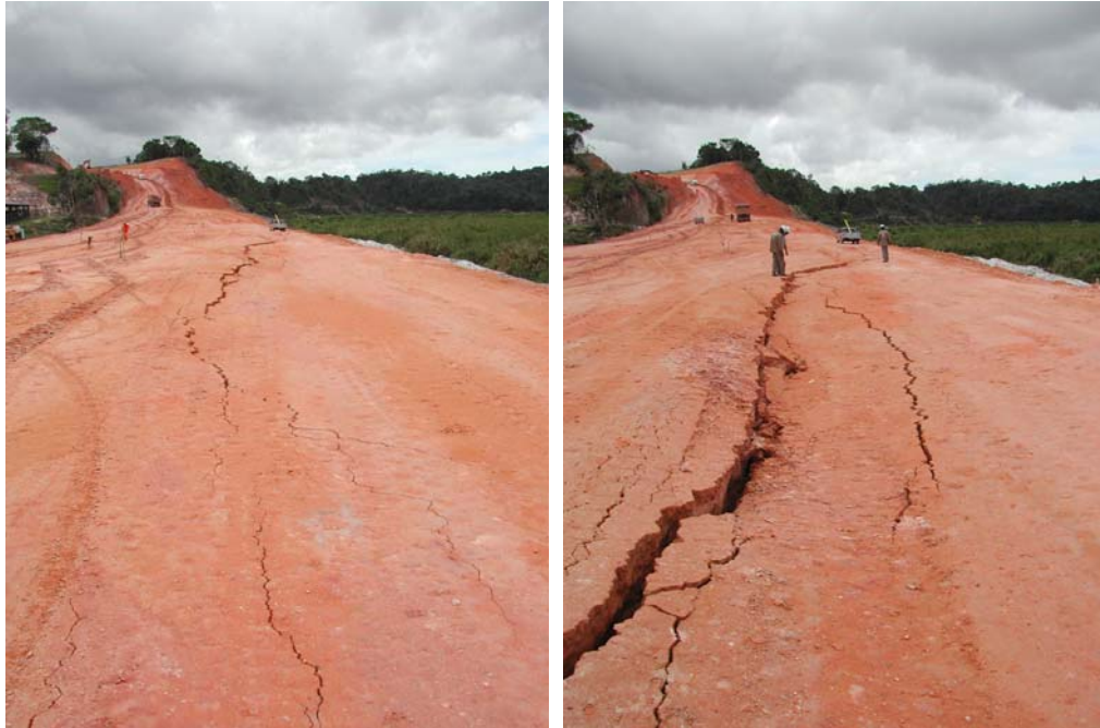
Figura 3.17 – Início de ruptura na área do rio João de Tiba.
