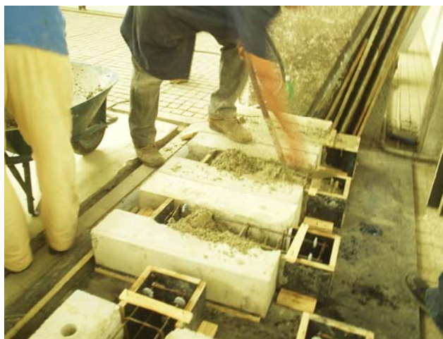
Figura 3.12 - Adensamento do concreto dos espécimes, com vibrador de imersão.
