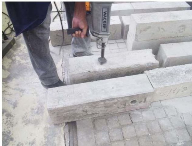
Figura 3.4 - Escarificação na superfície de um dos elementos laterais dos espécimes.
