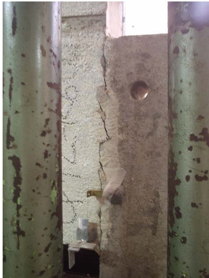
Figura 4.20 - Aspecto do exemplar E12R 12-3 após a ruptura.
