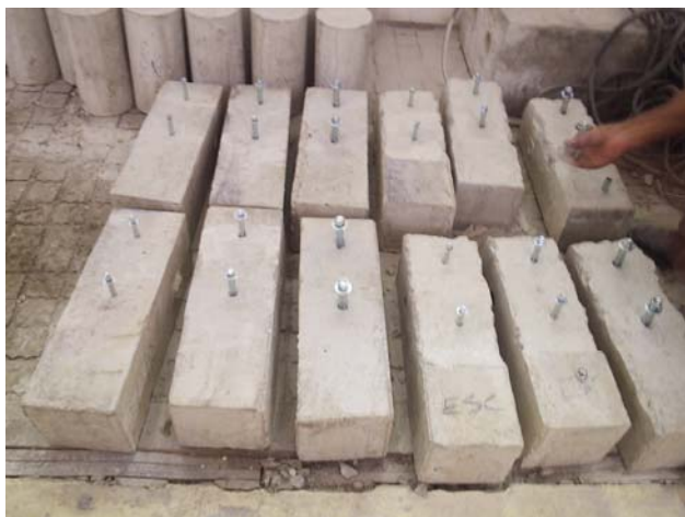
Figura 3.13 - Colocação dos chumbadores.
