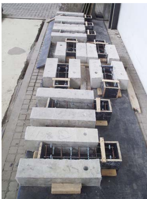
Figura 3.14 - Montagem das formas e armaduras para concretagem dos elementos centrais dos espécimes.
