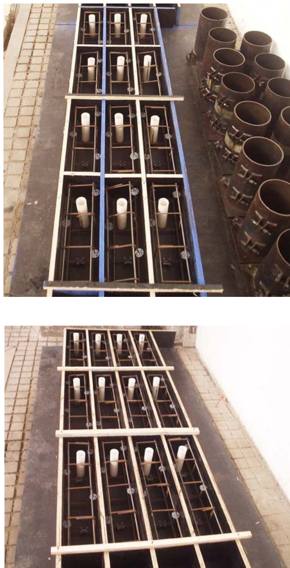
Figura 3.9 - Vista geral das fôrmas usadas para a concretagem dos elementos laterais dos espécimes.
