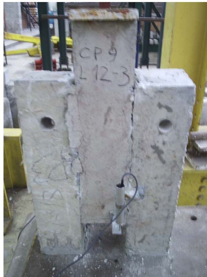
Figura 4.18 - Aspecto do exemplar E9L 12-3 após a ruptura.
