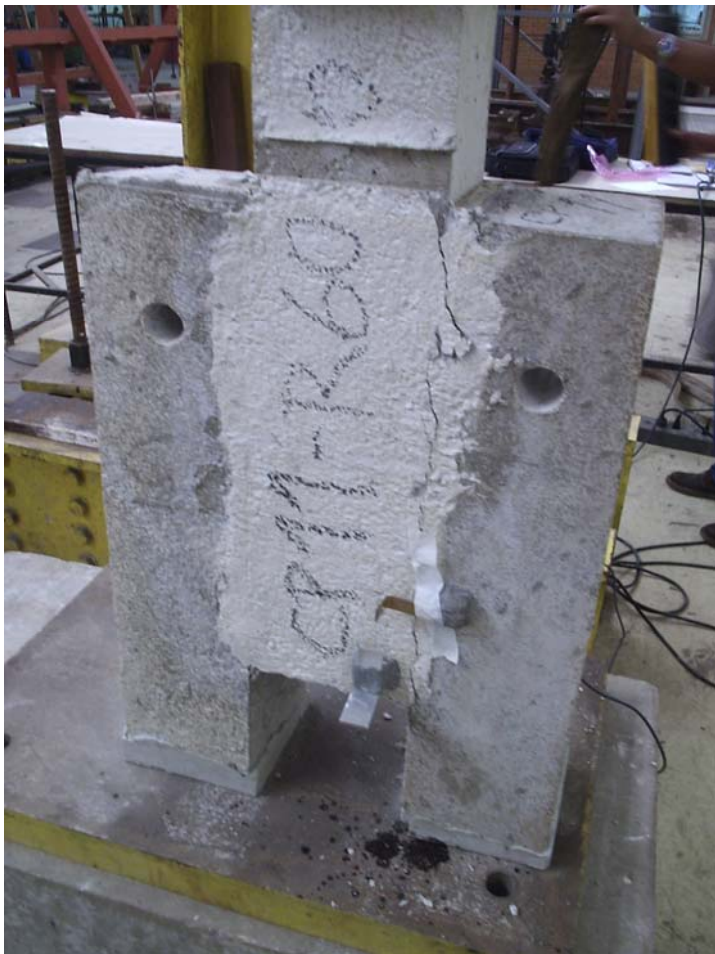
Figura 4.19 - Aspecto do exemplar E11R 10-3 após a ruptura.
