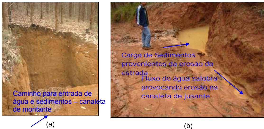
Figura 1-3 – Caminhos de entrada e saída de sedimentos em relação ao poço de infiltração: (a) Entrada de sedimentos pelas canaletas de montante; (b) Entrada de sedimentos provenientes da erosão da estrada e saída de sedimentos pelas canaletas de jusante.
