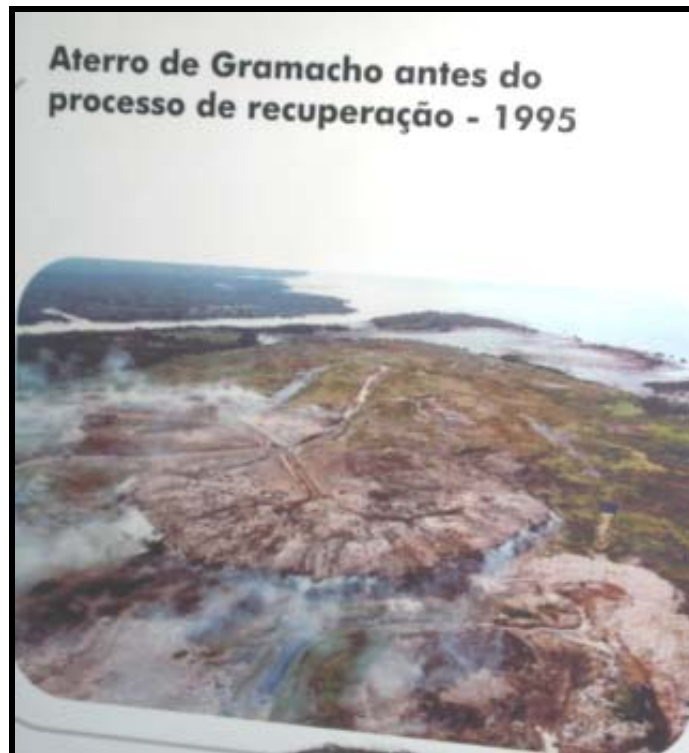
Figura 3.3: Aterro de Gramacho antes do processo de recuperação de 1995. (Painel exposto no Auditório da COMLURB em Gramacho, 2007).
