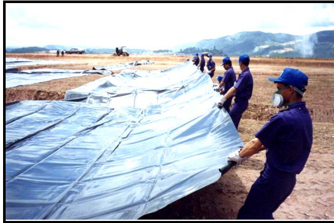
Figura 2.5: Colocação de geomembrana para revestimento de fundo – Aterro Bandeirante /SP (KAIMOTO et al , 2006).
