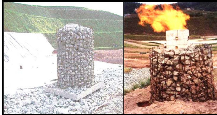
Figura 2.8: Sistema de drenos do aterro Bandeirantes/SP (KAIMOTO et al , 2005). Queima de biogás no flare.
