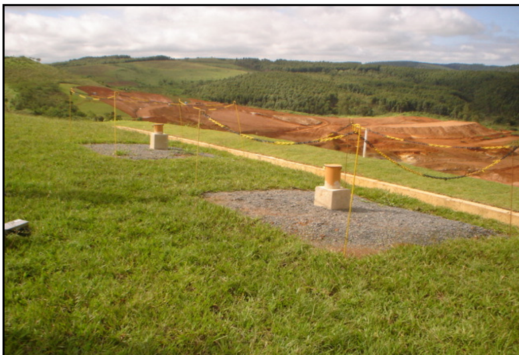
Figura 3.18 – Inclínômetro I-03 e piezômetro PZC-3 na cota 1.320,3 dique leste.
