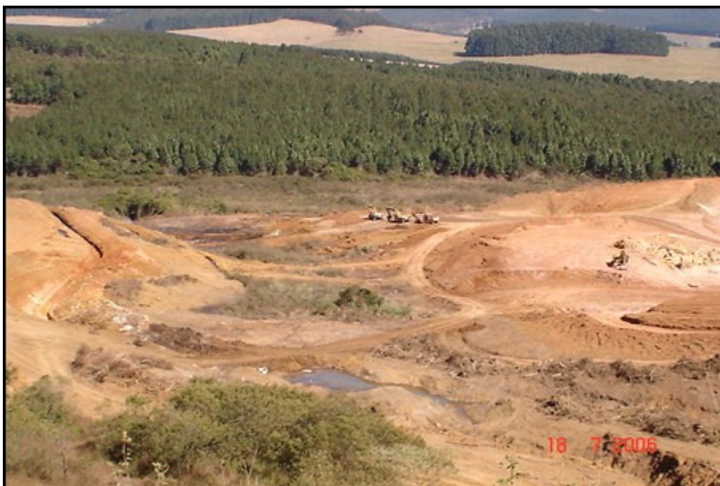
Figura B. 3- Mês de julho de 2006- Início da remoção do solo mole na área “A”.
