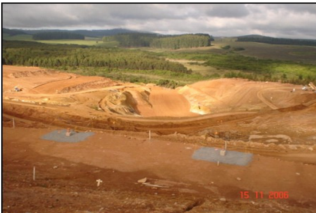
Figura B. 11-Mês de novembro de 2006- Vista da área de implantação do I5 e PZC-5 com escavações a jusante, na área .
