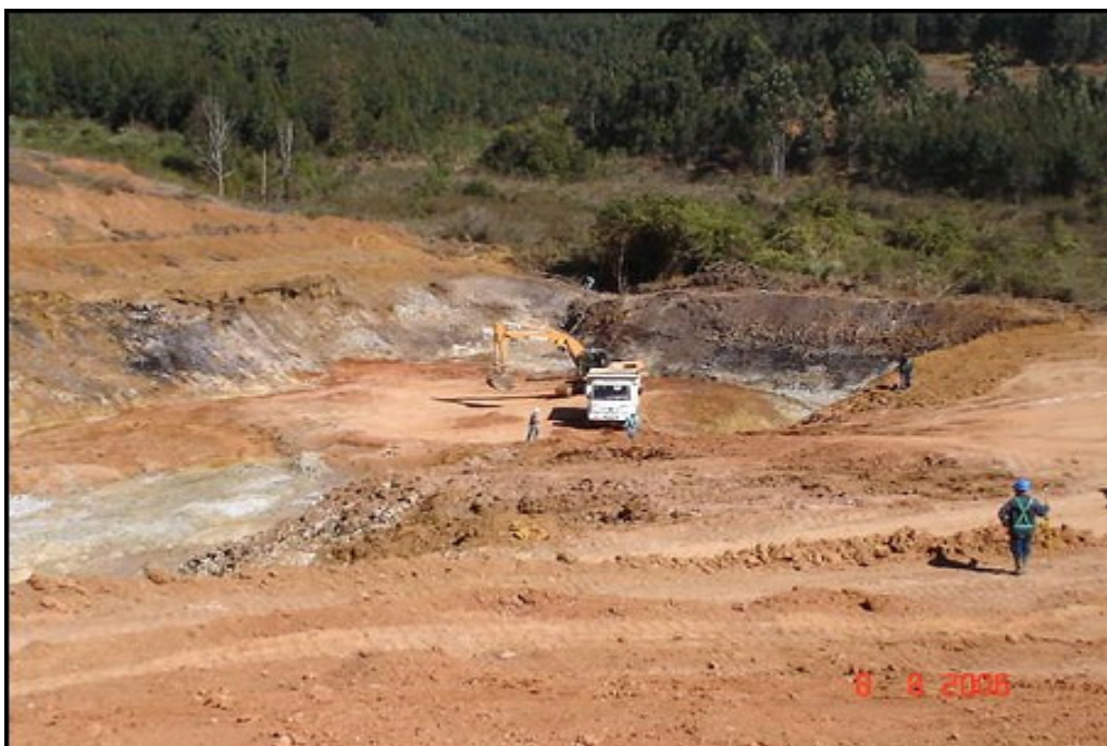
Figura B. 6- Mês de agosto de 2006- remoção de solo mole na área “A “de jusante para montante e utilização de camada de suporte.
