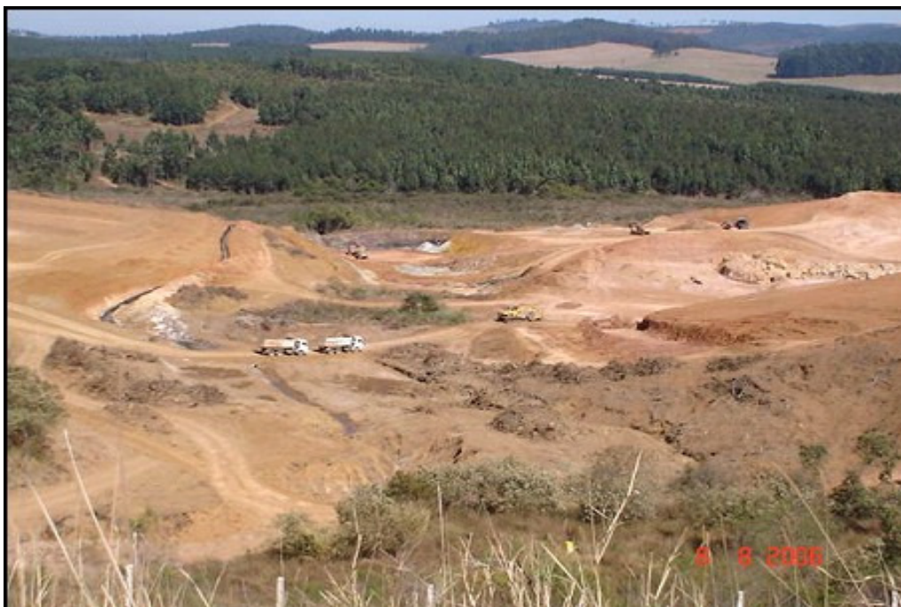
Figura B. 7- Mês de agosto de 2006- Aterro do dique oeste e remoção de solos moles na área “A” localizada a jusante do I7, I8 e PZC-7.
