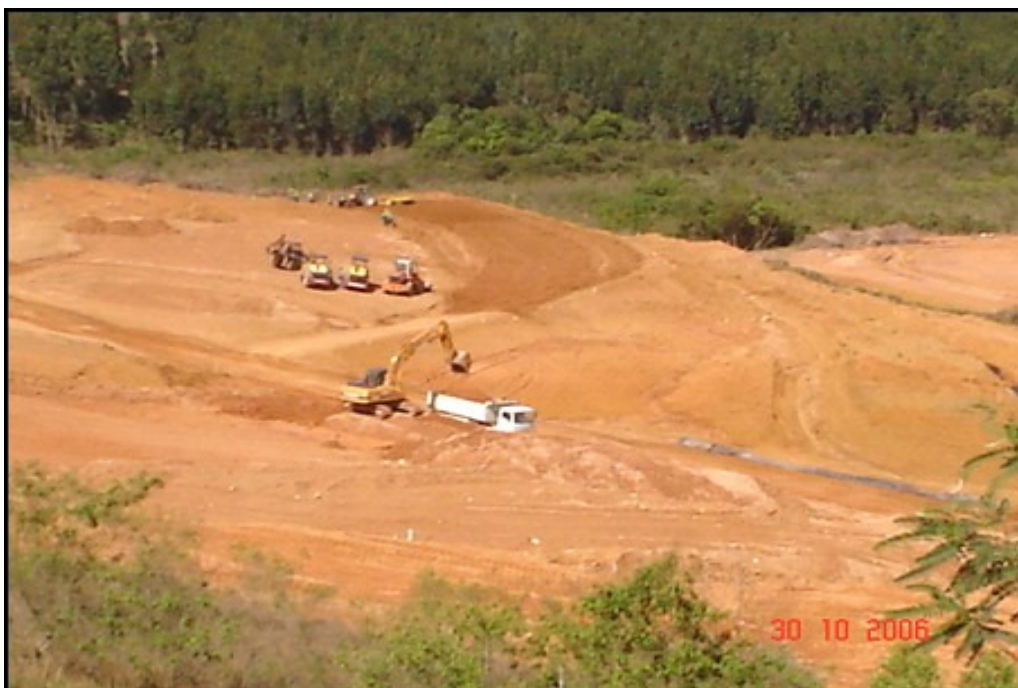
Figura B. 9- Mês de outubro de 2006- Escavações a jusante do I3 e PZC-3.
