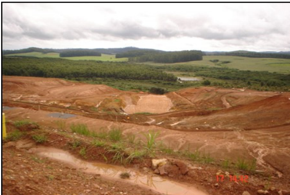
Figura B. 13- Mês de dezembro de 2006- Vista da berma de instalação do I5 e PZC-5.
