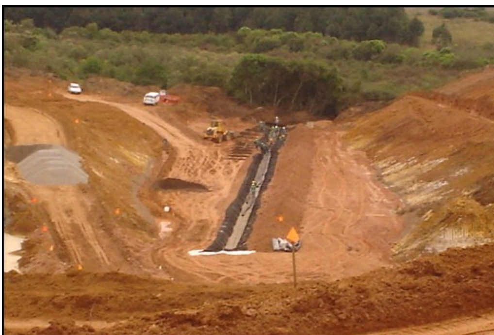
Figura B. 8- Mês de setembro de 2006- Vista da área de solos moles “B” localizada a jusante do I5 e PZC-5 (instalação da drenagem).
