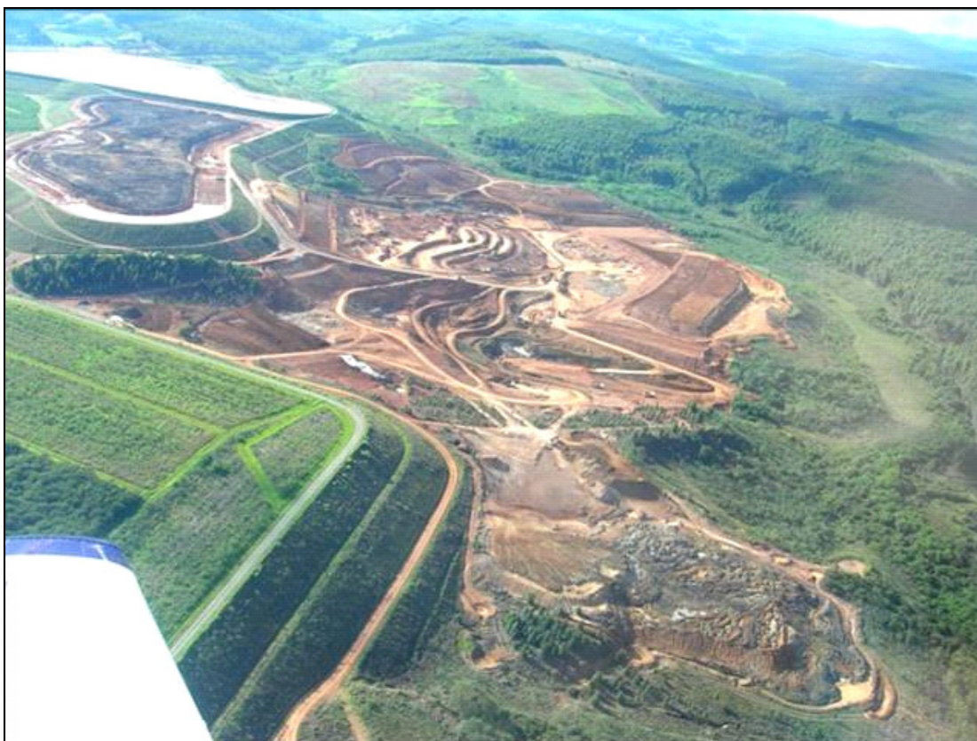
Figura 3.1 – Vista aérea da área em estudo (sentido Norte-Sul).
