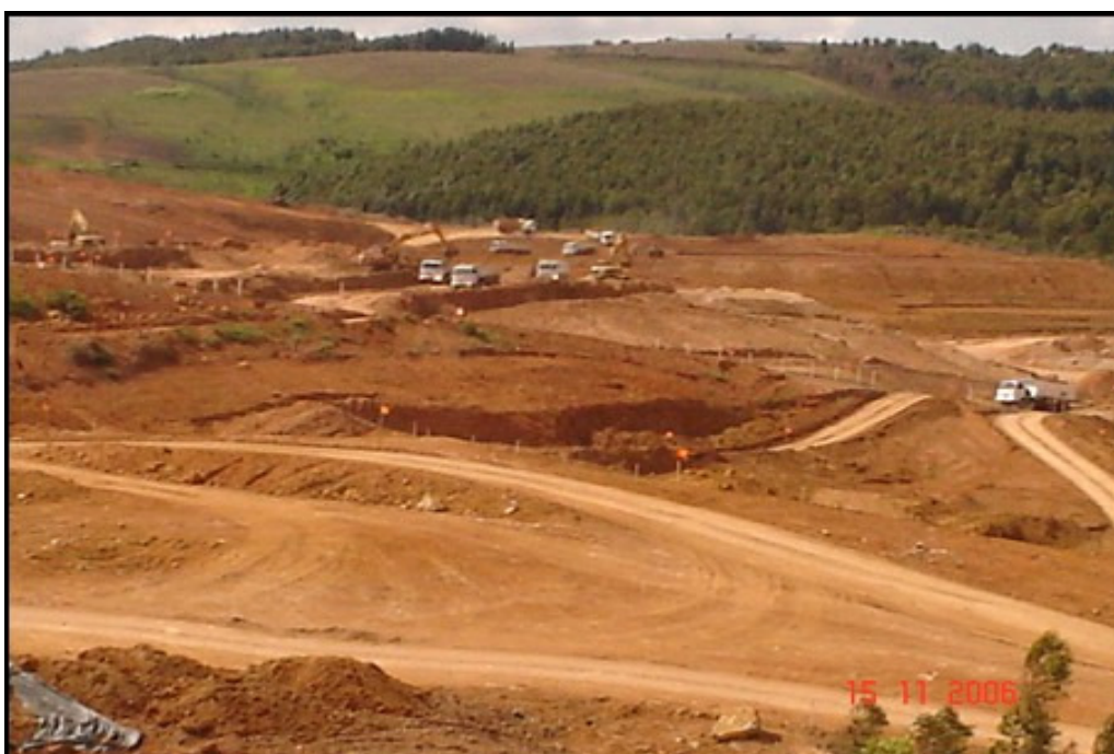
Figura B. 12 - Mês de novembro de 2006 - Vista das escavações à jusante do I4, PZC-4, I5 e PZC-5.
