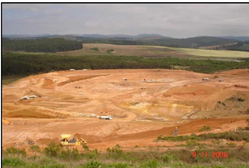
Figura B. 10- Mês de novembro de 2006- Escavações à jusante do I1 e PZC-1 localizados no dique sul.
