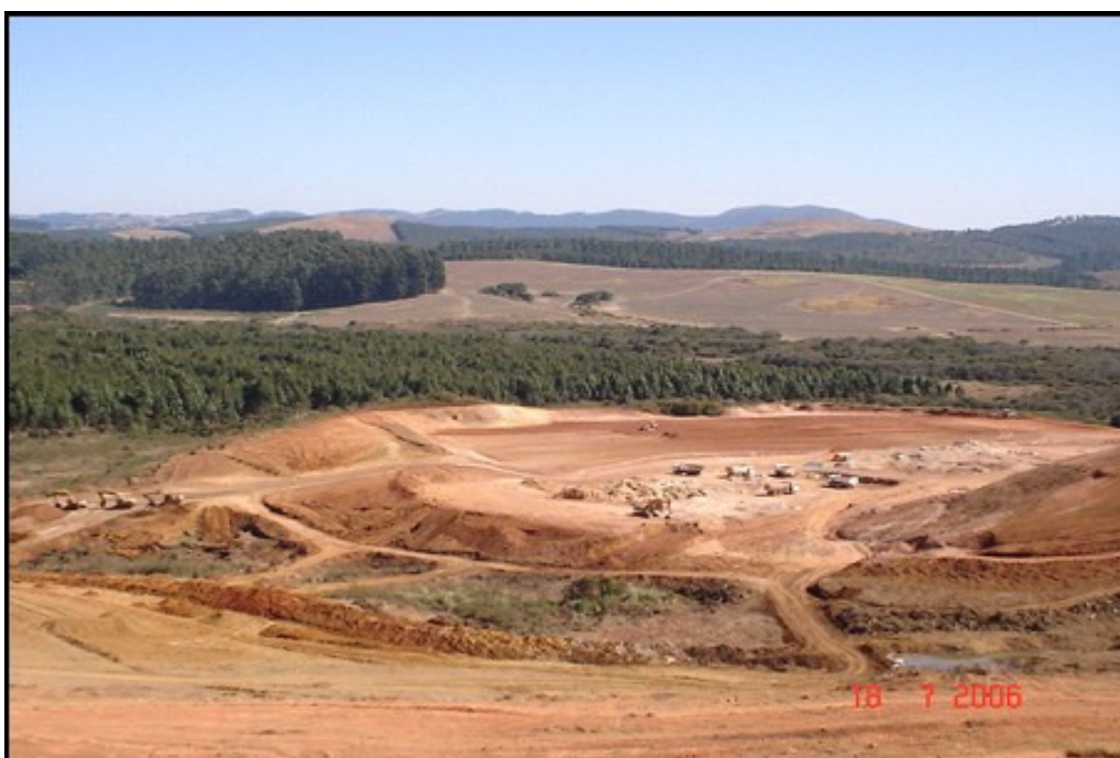
Figura B.4- Mês de julho de 2006- Visão do aterro do dique oeste e área de remoção de solos moles “A” do local de instalação do I1 e PZC-1.
