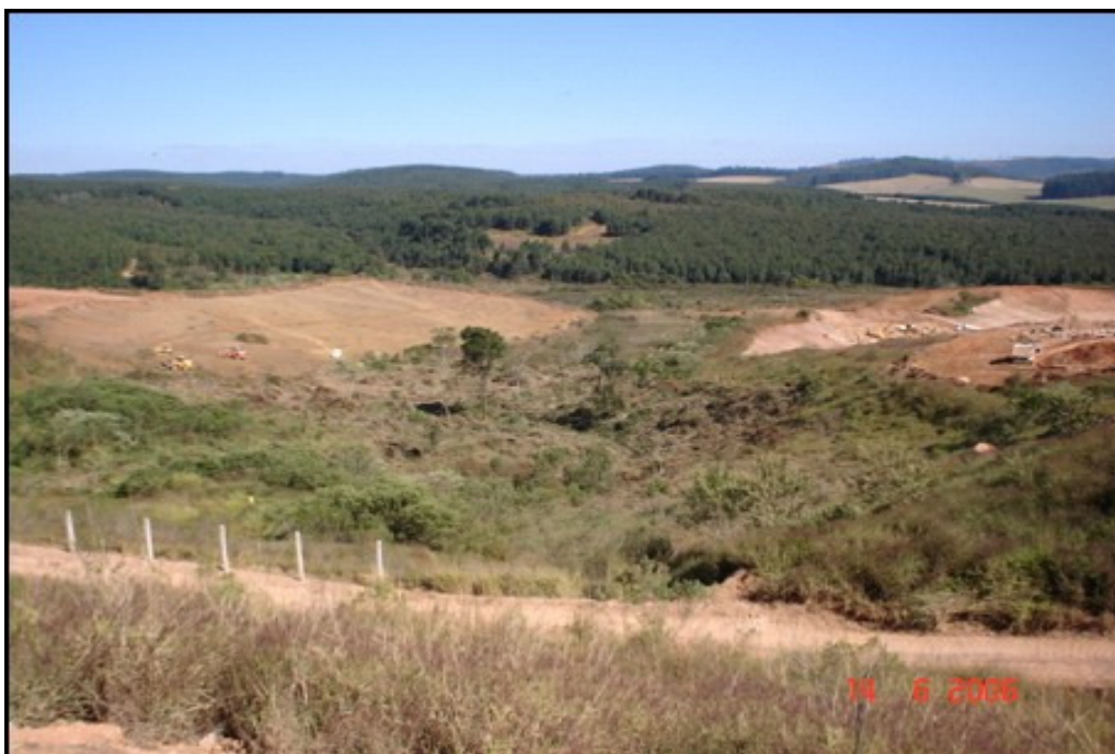
Figura B.1- Mês de junho de 2006- Início da obra, visão da área de solos moles a remover.
