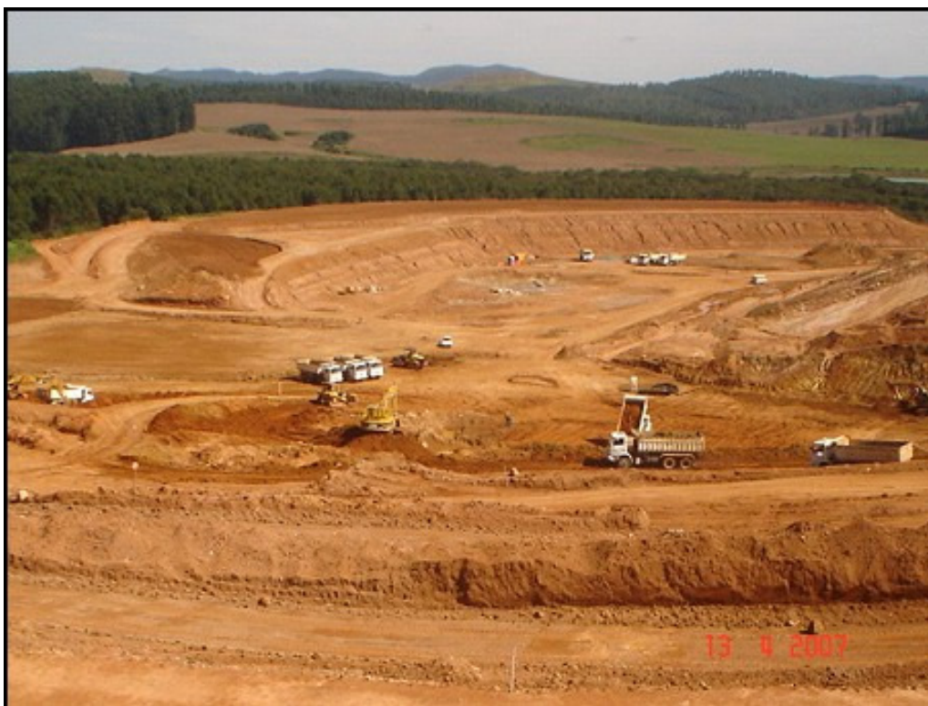
Figura B. 19- Mês de abril de 2007- Escavações à jusante do I2 e PZC-2 e aterro do dique oeste.
