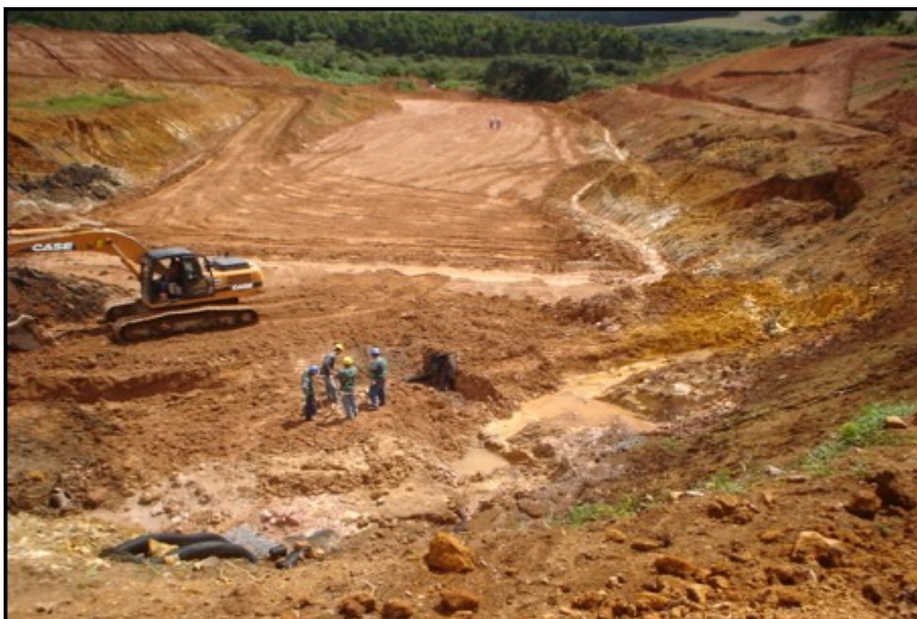
Figura B. 15- Mês de fevereiro de 2007- Escavação na área de solos moles “B” localizada à jusante do I5 e PZC-5.
