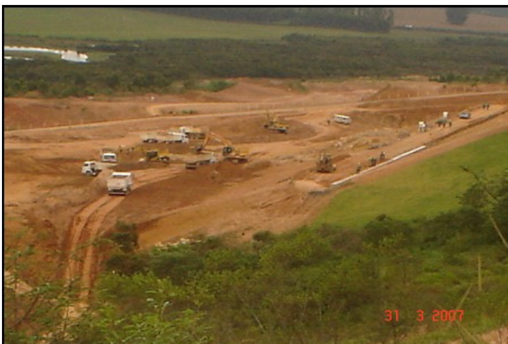
Figura B. 18- Mês de março de 2007- Escavações no dique leste à jusante do I4 e PZC-4.
