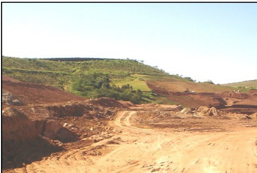
Figura B. 16- Mês de fevereiro de 2007- Escavações no dique leste à jusante do I4 e PZC-4 e dique sul à jusante do I2 e PZC-2.
