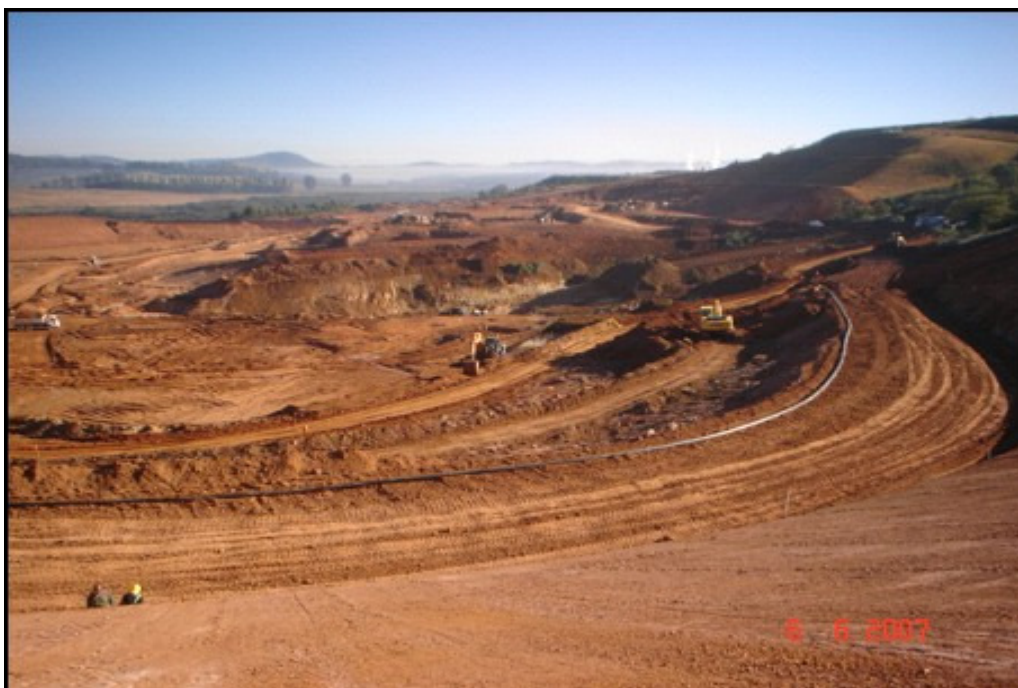
Figura B. 21- Mês de junho de 2007- Escavações à jusante do I2 e PZC-2, no dique sul.
