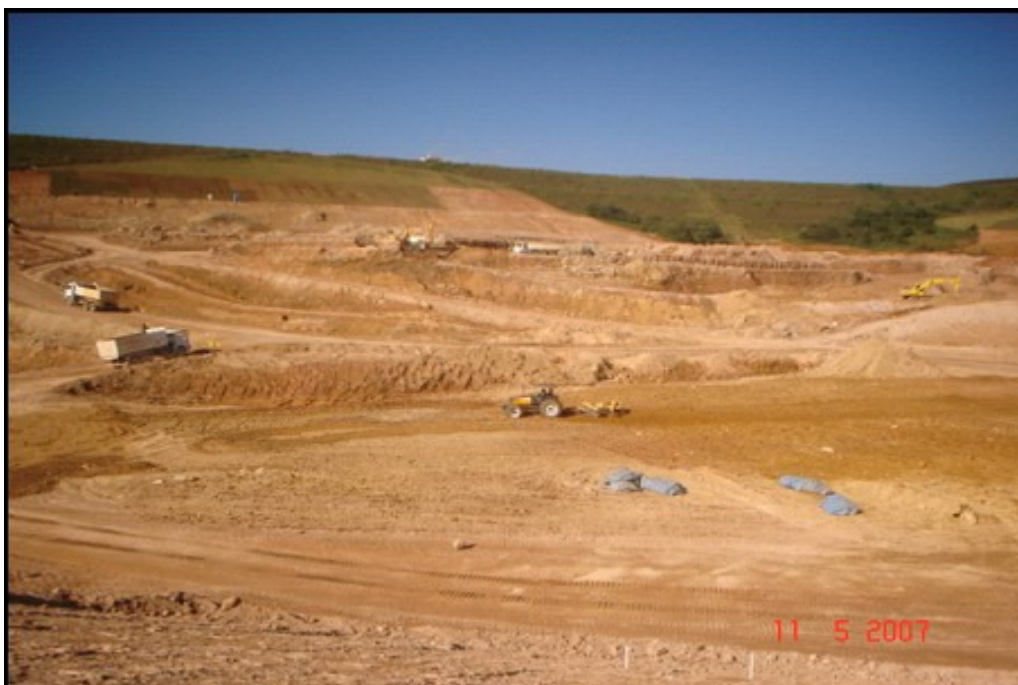
Figura B. 20- Mês de maio de 2007- Escavações no dique leste à jusante do I4 e PZC-4.
