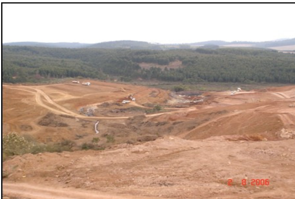
Figura B. 5- Mês de agosto de 2006- Execução de trincheiras drenantes para remoção de solos moles na área “A”, vista do local de implantação do I1 e PZC-1.
