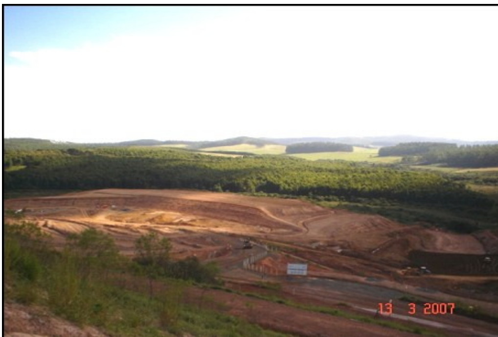
Figura B. 17- Mês de março de 2007- Vista geral do aterro do dique oeste.
