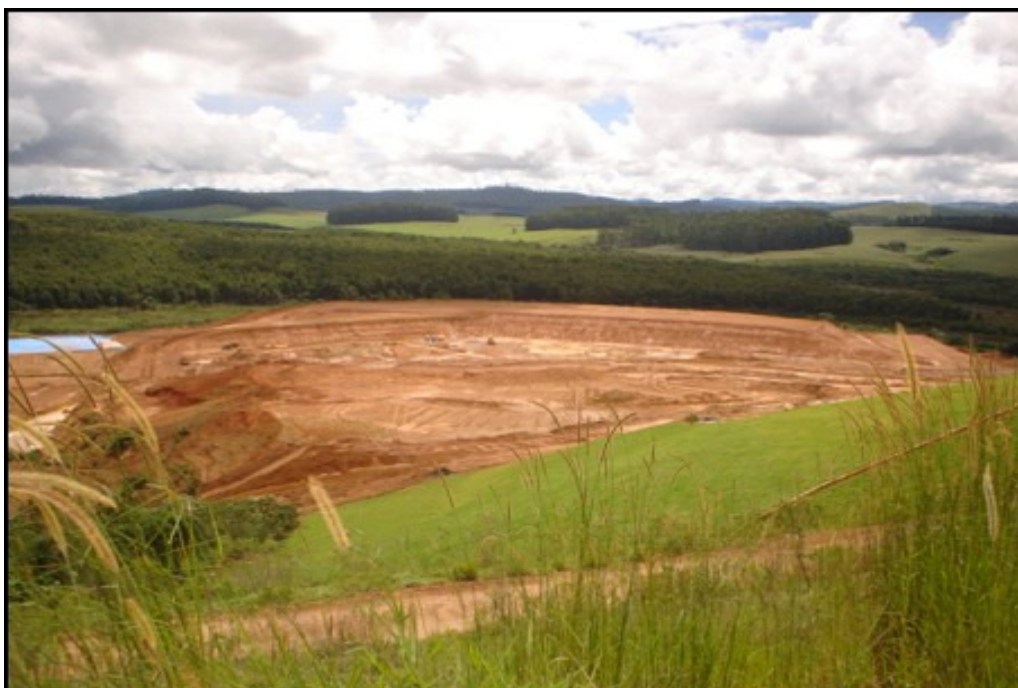
Figura B. 14- Mês de janeiro de 2007- Vista do aterro do dique oeste e talude revestido no dique leste.
