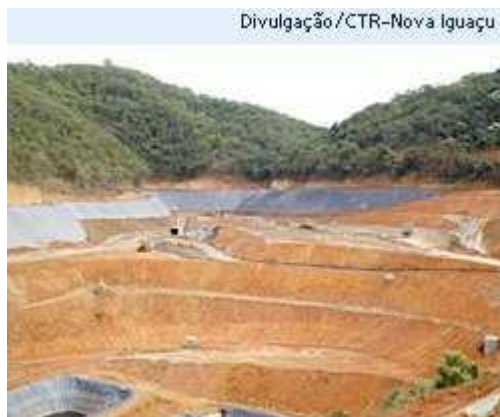
Figura 19: Vista construção CTR Nova Iguaçu – Fonte:
