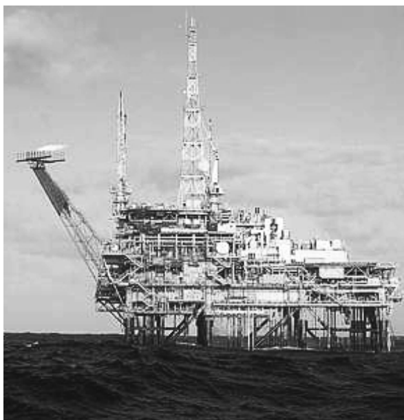
Figura 2.13 – Plataforma Central de Enchova 01
