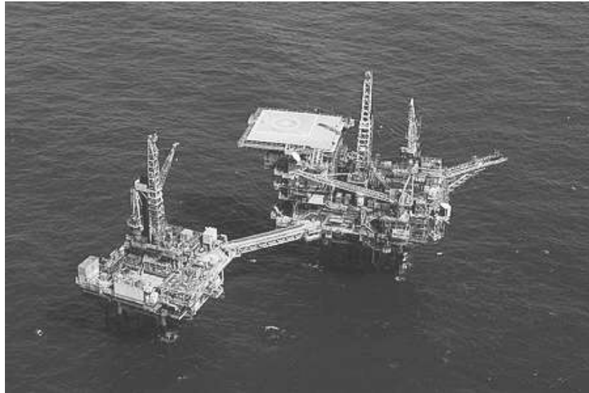
Figura 2.15 – Plataformas de Carapeba 01 e 03
