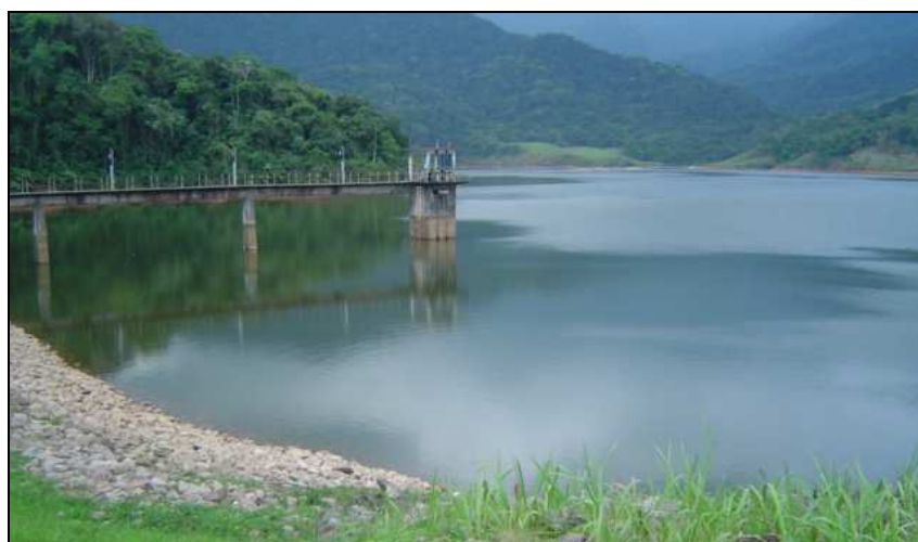
Foto 4.2 – Represa de Saracuruna, no centro a torre de captação.
