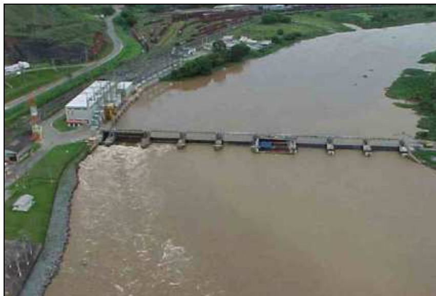
Foto 3.4 - Barragem e estação elevatória de Santa Cecília
