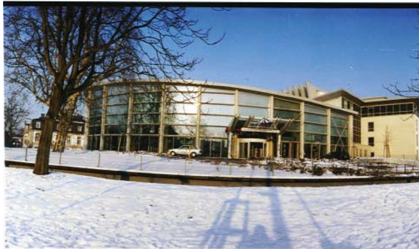
Figura 5.22 – Fachada do Hotel Arabella-Sheraton fonte: NOLDE, 2000
