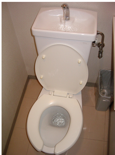
Figura 5.20 – Bacia sanitária com reúso direto fonte: http://makinglifeeasy.org/tag/greenissues
