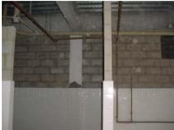
Figura 5.29 – Tubulações de descida das águas pluviais Figura 5.30 – Tubulações de distribuição da água de reúso fonte: RIOURBE, 2004
