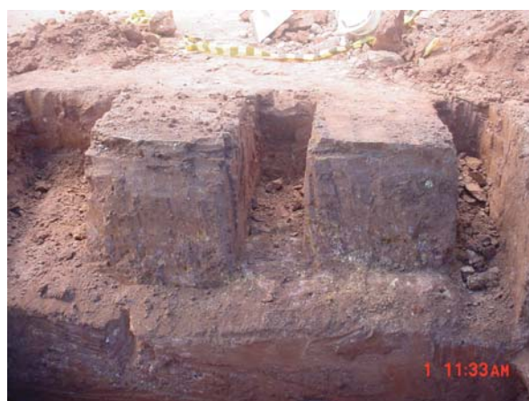
Figura 3.5 – Início da moldagem dos blocos.
