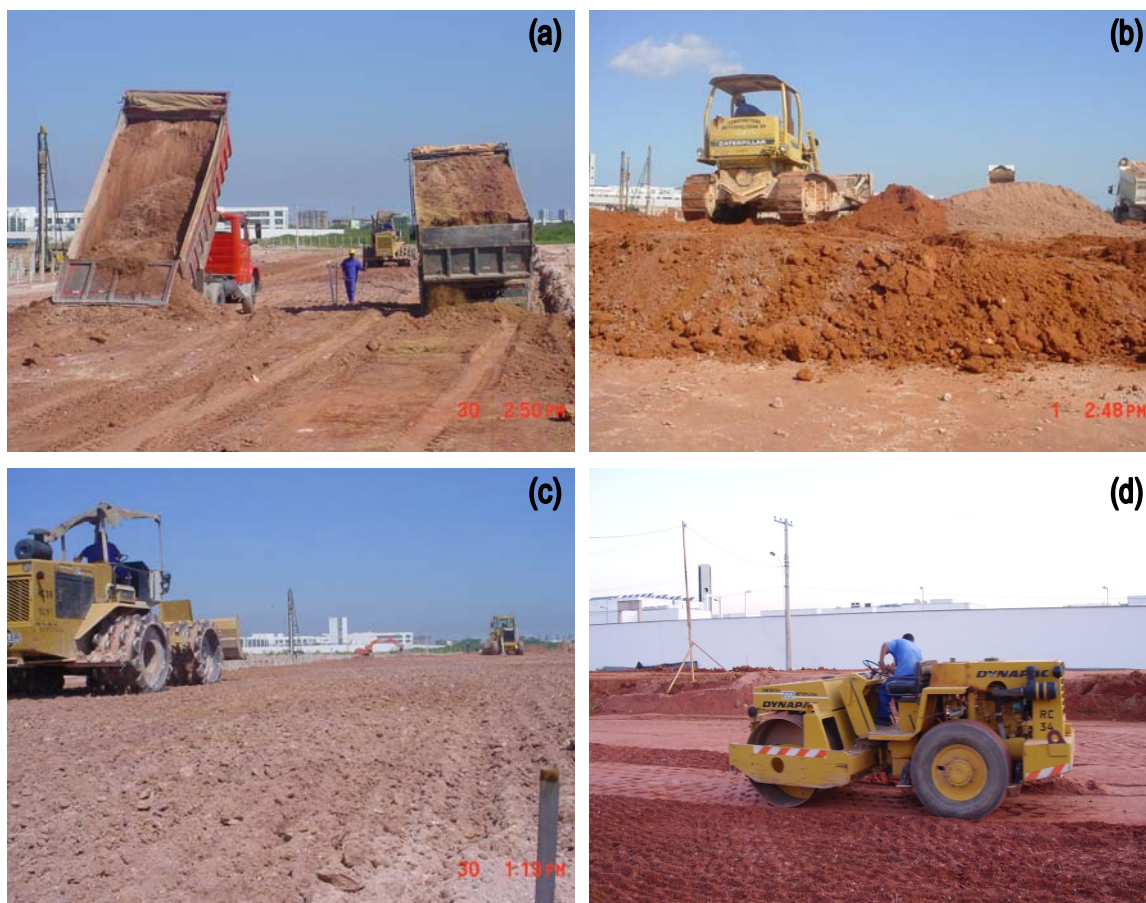
Figura 3.3 – Processo de compactação
