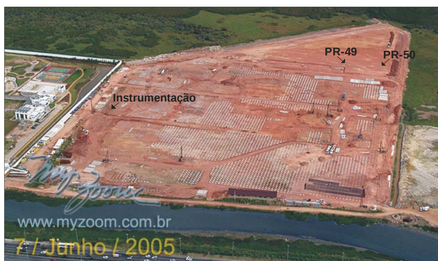
Figura 3.1 – Vista geral da obra e ponto de amostragem
