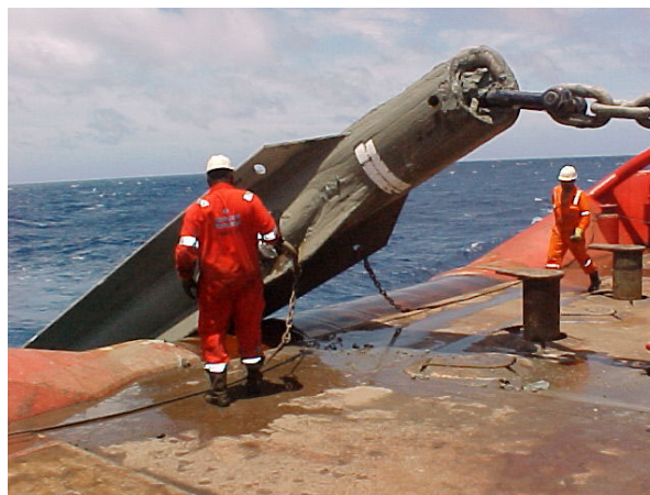
Figura 2.18. Lançamento de estaca torpedo para ancoragem de MODU.
