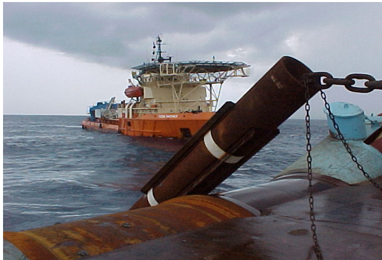
Figura 2.17. Lançamento de estaca torpedo para ancoragem de risers .
