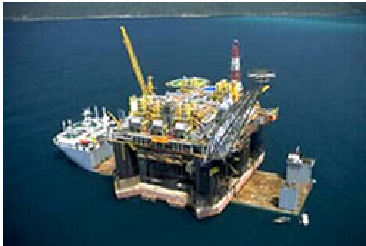
Figura 2.5. Transporte de uma semi-submersível para o local de instalação.
