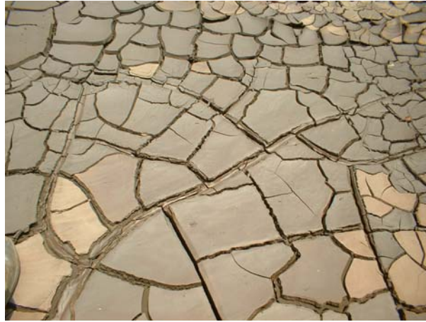
Figura 2.9: ressecamento da superfície do reservatório de rejeito
