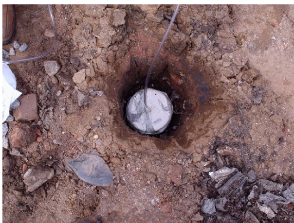
Foto 9 - DMPC alojado na base da camada de cobertura
