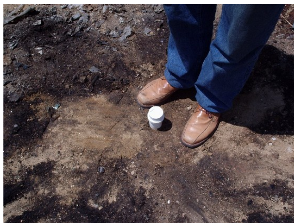
Foto 6 - Dreno de gases A-1.30 instalado
