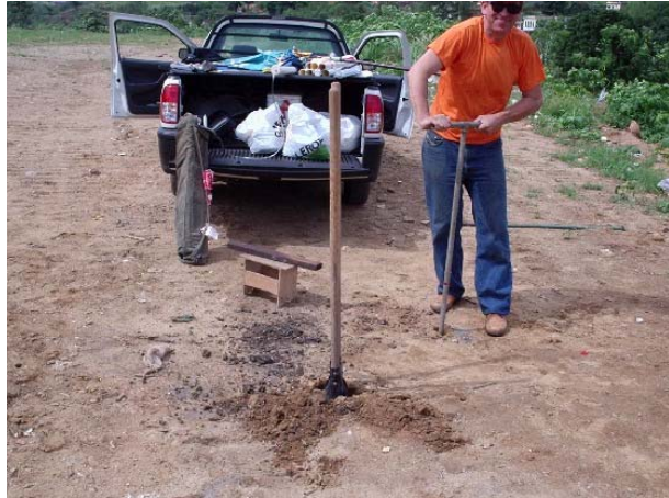
Foto 2 - Início das perfurações na Estação A
