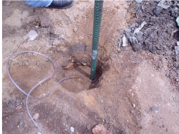
Foto 10 - compactação da argila no DMPC
