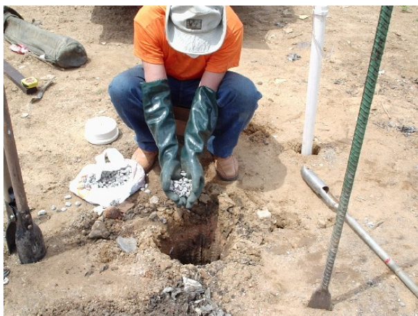
Foto 7 - colocação de brita no furo do DMPC
