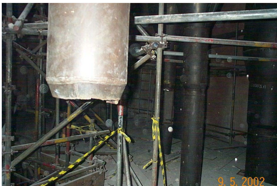
Figura VI.4 – Detalhe da fratura de um ciclone de segundo estágio. Ao redor pode se notar andaime e plataforma montada no interior do regenerador para iniciar o reparo dos ciclones.
