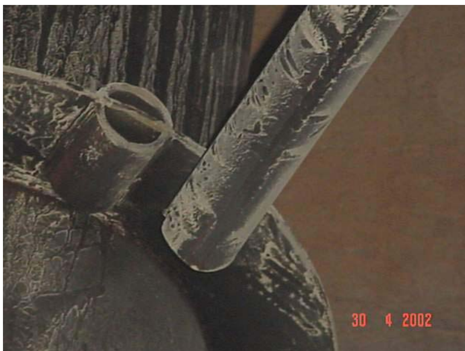
Figura VI.5 – Detalhe da ruptura de um dos travejamentos.
