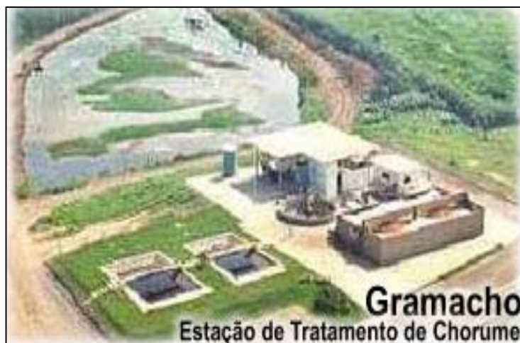
Figura 1.4 – Estação de tratamento de chorume do Aterro de Gramacho 3
