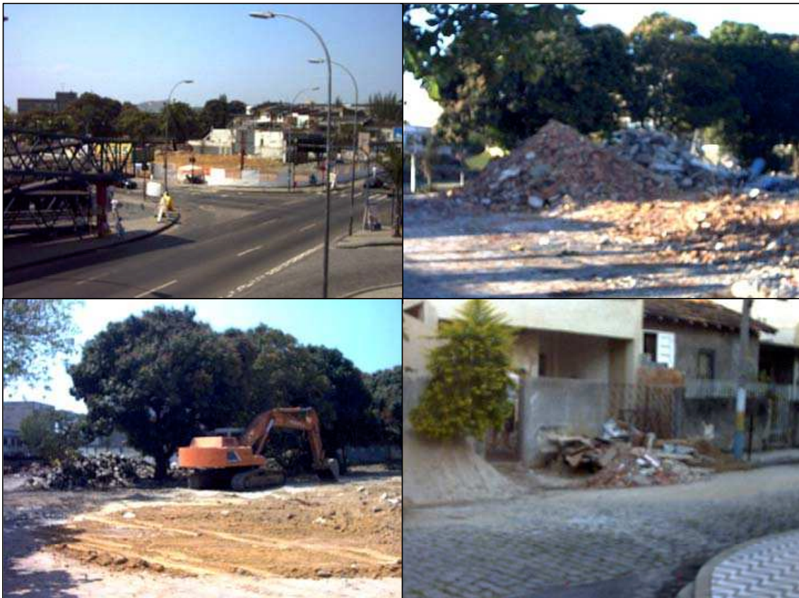
Figura 2.1 – Vista geral onde será construído o novo Hospital Paulino Werneck; pilhas de RCD; equipamento (escavadeira) utilizado na demolição das edificações então existentes e remoção de RCD; RCD proveniente de reforma domiciliar. (Fotos do autor).
