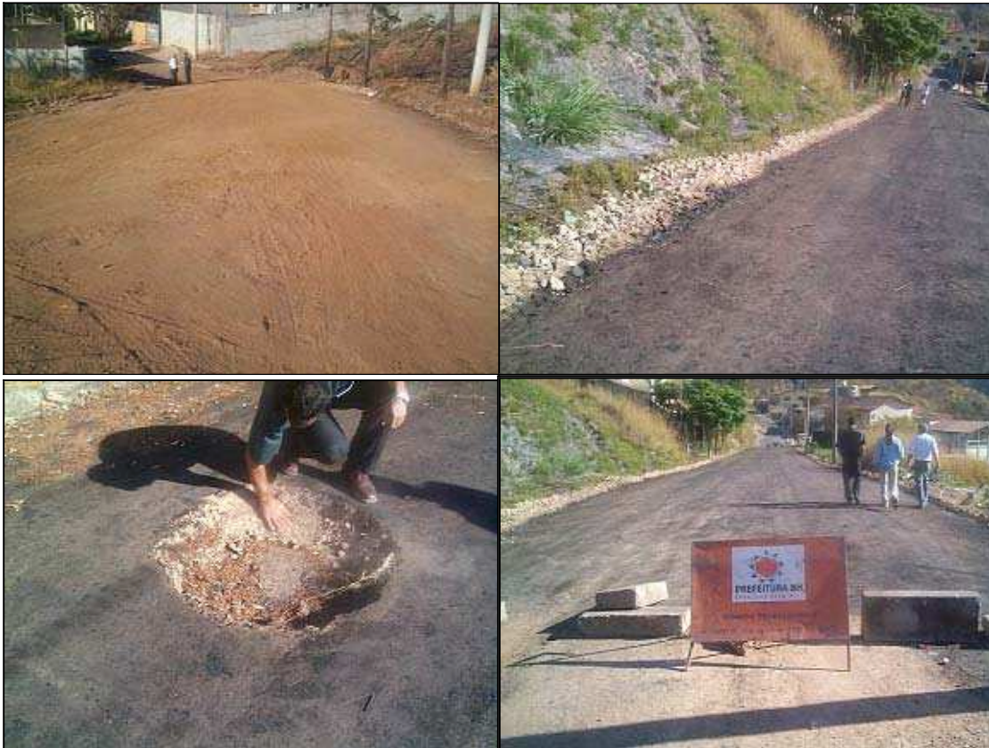
Figura 3.1 – Rua em Belo Horizonte antes da imprimação; rua imprimada com partículas segregadas à margem; ponto do pavimento a ser reparado e visulaização da brita corrida compactada; rua imprimada. (Fotos do autor, ago/2003).
