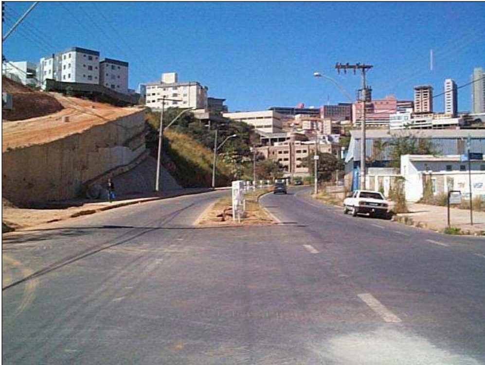
Figura 2.2 – Av. Mário Werneck, com trecho executado com agregado reciclado. (Foto do autor, ago/2003).
