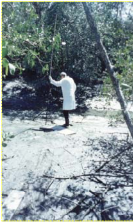
Figura 3.10a - Piezômetros P-2 (acima) e instalação da régua de maré (abaixo).
