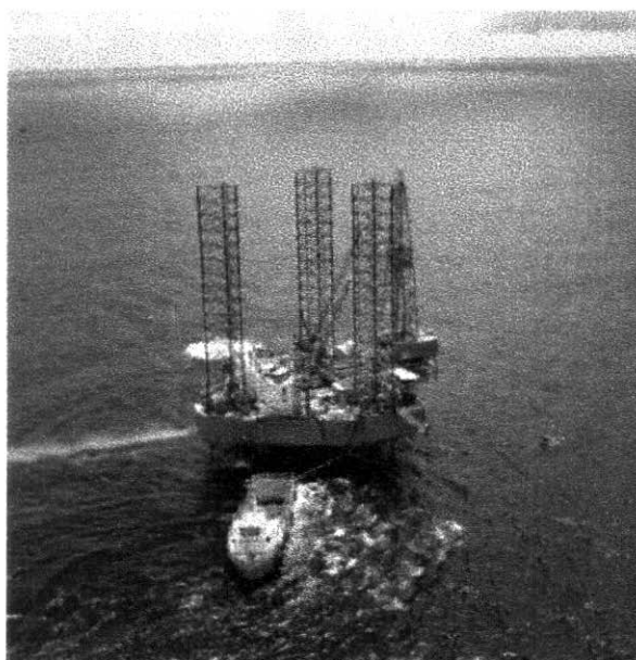
Figura I-5 - Plataforma Auto-Elevatória instalada na Bacia de Campos
