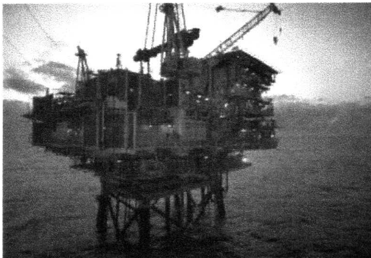
Figura I-2 - Plataforma fixa suportada por Jaqueta instalada na Bacia de Campos
