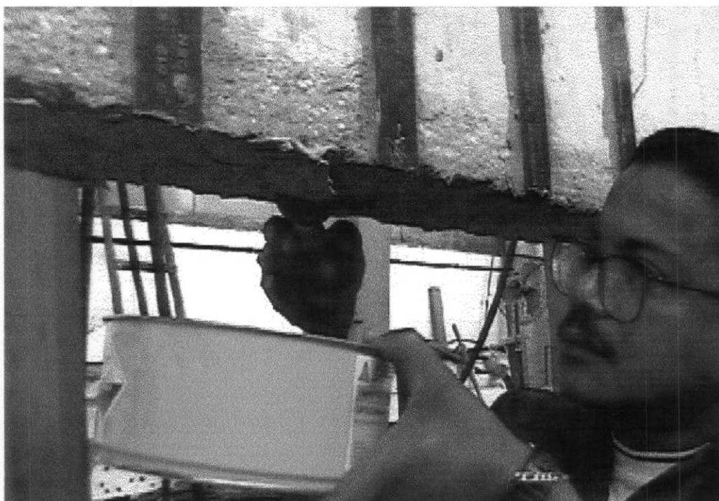
Foto A.7 – Aplicação da resina sobre a superfície da viga.
