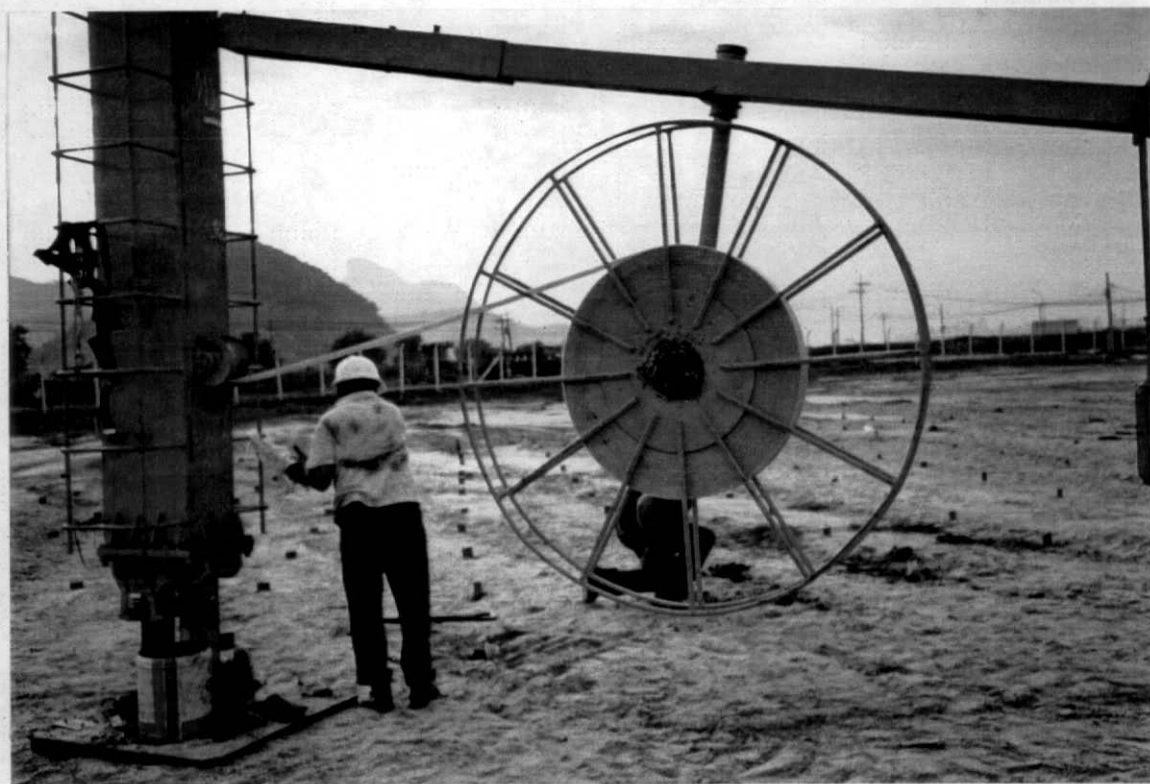
Fig. 4.10 Instalação dos Drenos Verticais
