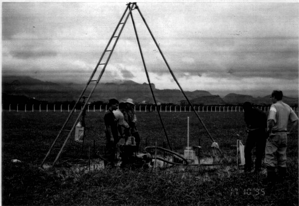
Fig. 4.9 Instalação da Instrumentação Geotécnica
