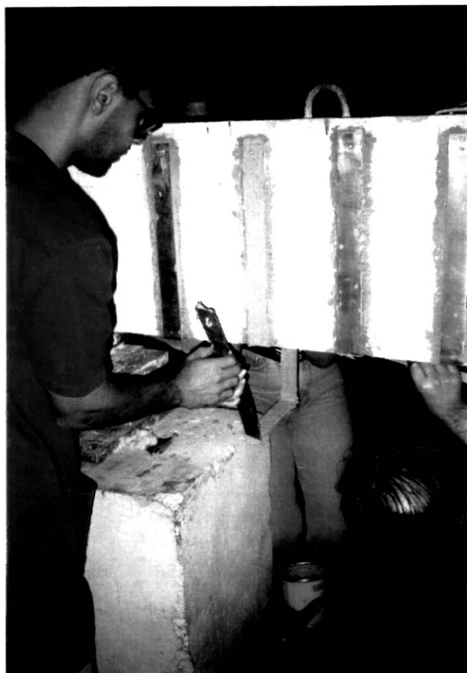
FOTO 16 - Colocação da 2ª camada de estribo de chapa
