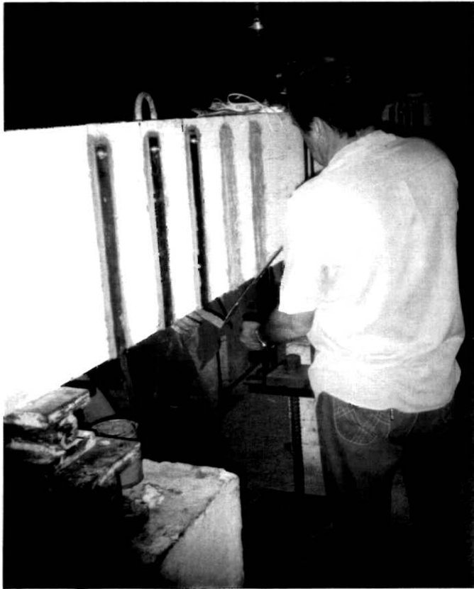
FOTO 13 - Colocação do estribo de chapa na viga
