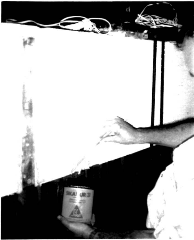
FOTO 12 - Aplicação da camada de resina epóxi na superfície da viga
