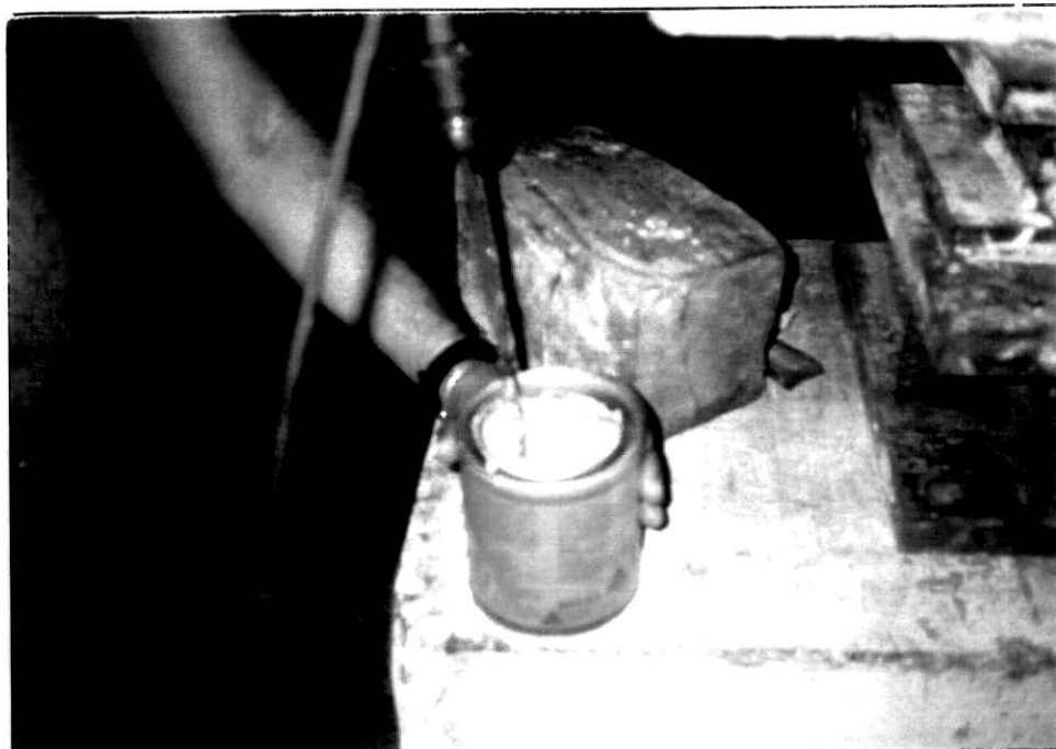
FOTO 10 - Mistura da resina epóxi usada para colagem dos estribos de chapa
