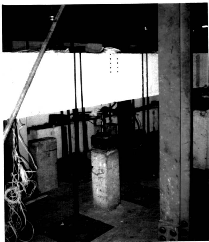
FOTO 23 - Sistemas para manutenção do carregamento durante o reforço da viga V2
