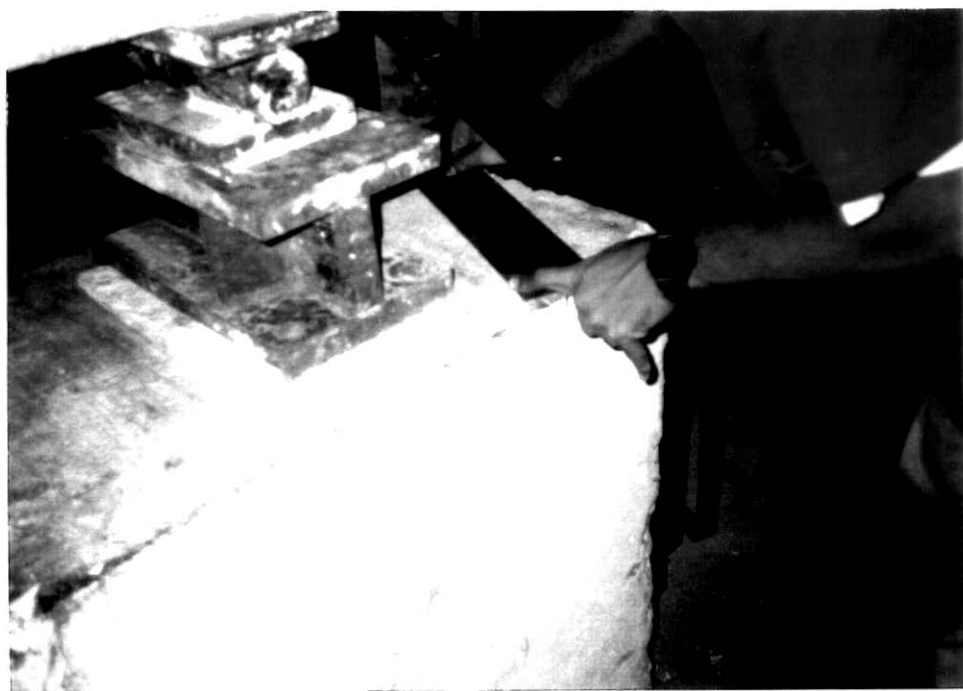
FOTO 7 - Preparação da superfície dos estribos de chapa: limpeza dos estribos com lixa de aço para remoção de substâncias que prejudicam a aderência
